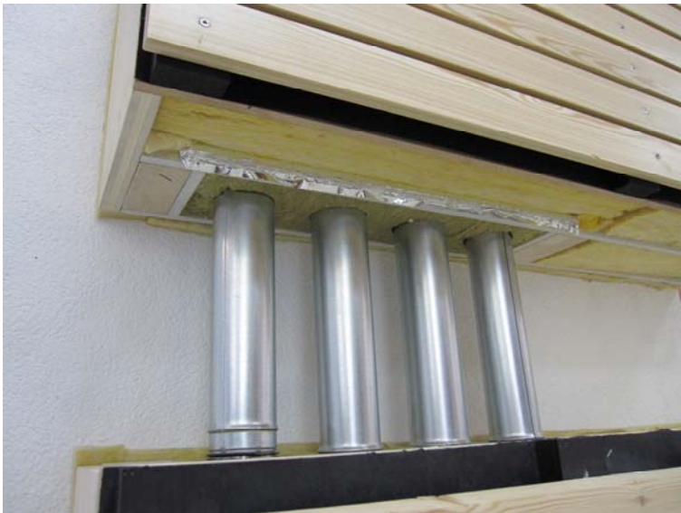
Figur 32: Demonstrationsmodell des Fassadenmodul mit Teleskopverbindungen der Lüftungsleitungen [09]
