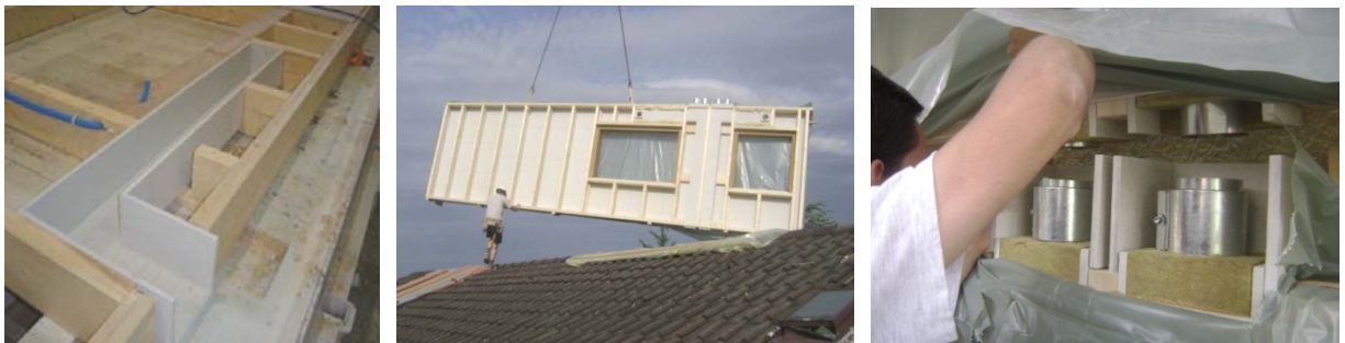
Figur 44: Vorfabrikation der Fassadenmodule mit Brandschutz für Lüftungsleitungen (links), Montage der Elemente (Mitte), Verbinden der integrierten Lüftungsrohre (rechts)
