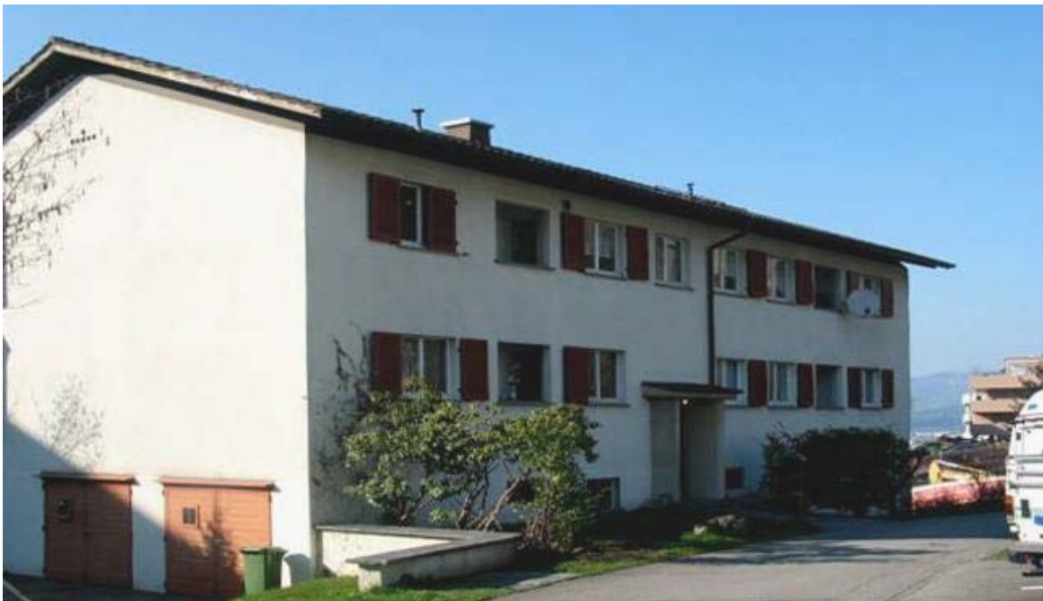
Figur 38: Nord-Ost-Fassade des typischen Mehrfamilienhauses aus der Nachkriegszeit
