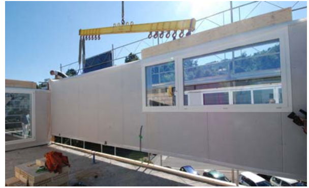
Figur 40: Der bestehende Dachboden wurde mit Verbundschrauben und Leichtbeton verstärkt (links), um anschliessend die vorgefertigten Leichtbau-Module aufnehmen zu können (rechts) [14].
