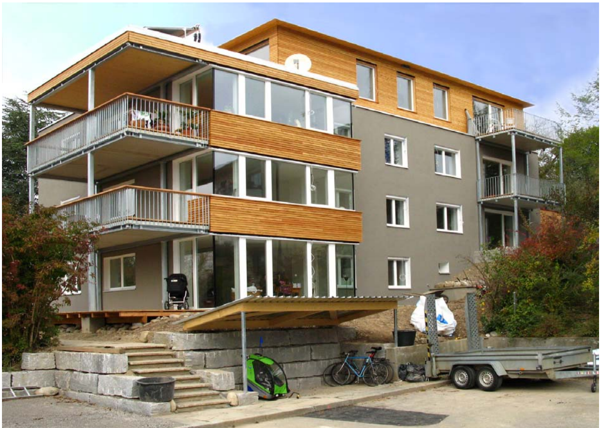
Figur 45: Das Gebäude ist nach der Renovation kaum mehr wiederzuerkennen. Die Modernisierung sichert die weitere Nutzung über Jahrzehnte [15].
