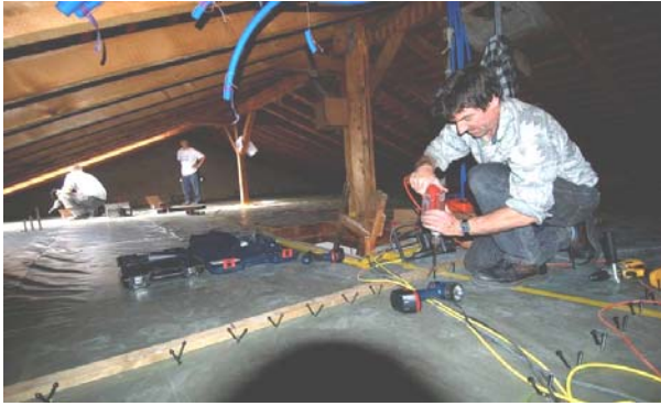
Figur 40: Der bestehende Dachboden wurde mit Verbundschrauben und Leichtbeton verstärkt (links), um anschliessend die vorgefertigten Leichtbau-Module aufnehmen zu können (rechts) [14].
