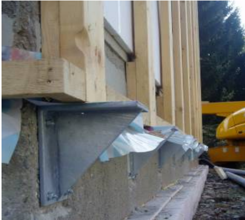
Figur 18: Stahlkonsolen als Auflager der Holzunterkonstruktion. Bsp. Dieselweg, Graz [17]
