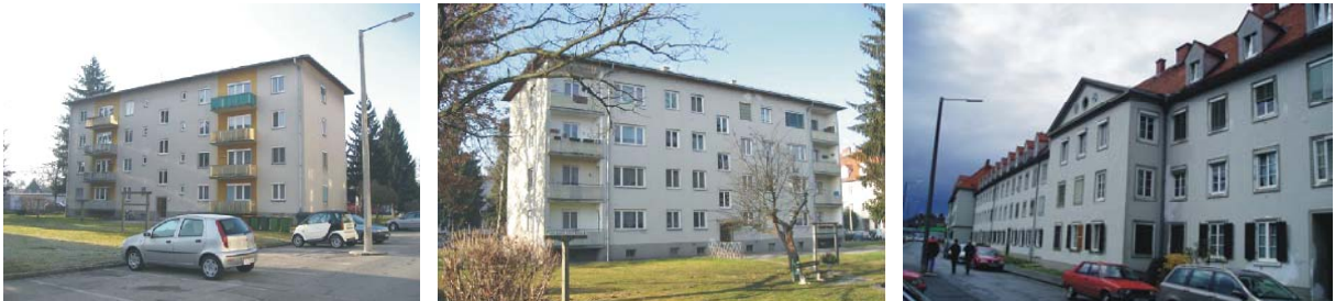
Figur 46: Erneuerte Wohnbauten am Stadtrand von Graz, Österreich
