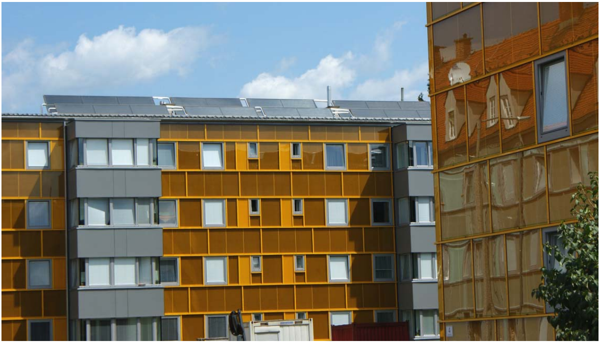
Figur 49: Renovierte Wohnsiedlung in Graz, mit verglasten Fassadenelementen, verglasten Balkonen und thermischen Kollektoren auf dem Dach [17]
