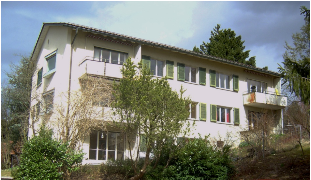
Figur 42: 5-Familienhaus in Zürich Höngg vor der Renovation [15]
