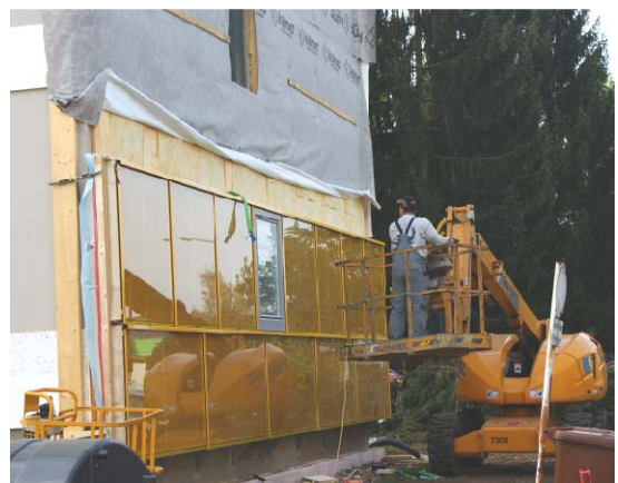
Figur 48: Vorfabrikation der Grosselemente in der Fabrik (links) und deren Montage vor Ort (rechts) [17]
