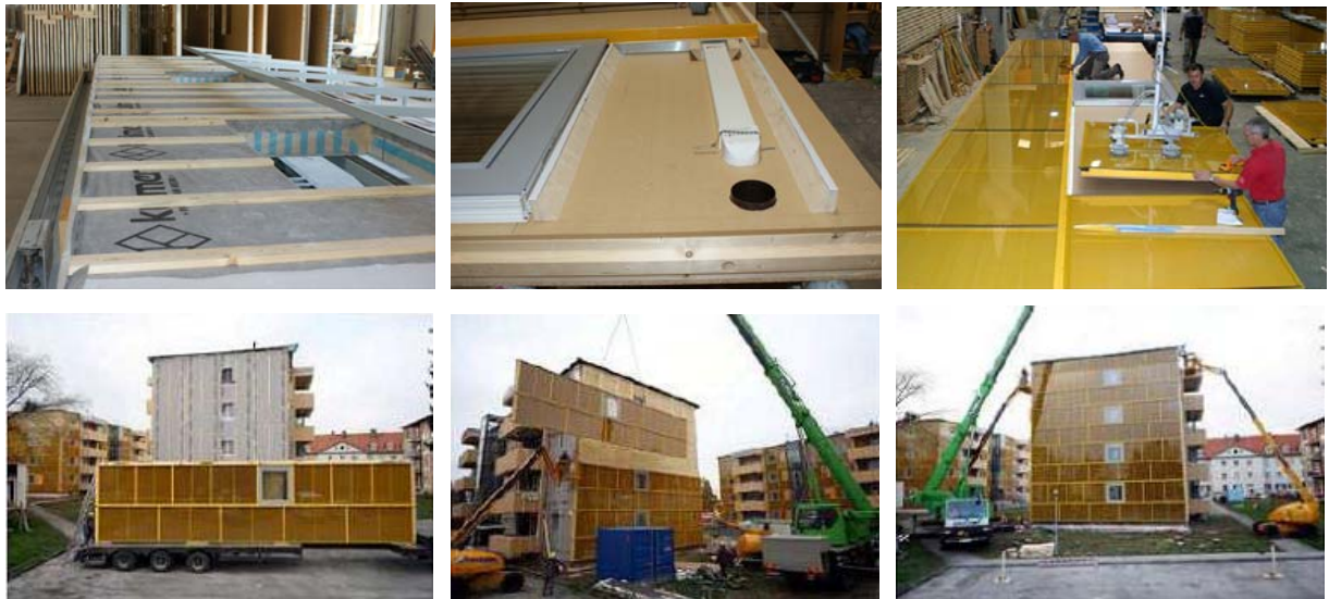
Figur 28: Herstellung und Montage der grossformatigen Fassadenmodule: von oben links: Unterkonstruktion aus Holz und Mineralwolle, Einbau der Einzelraumlüfter, Verkleidung mit Glaselement, Transport, Montage mit Hebekran und 2 Montagebühnen, fertig gestellte Fassade [10]
