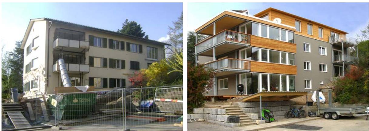
Figur 3: Beispiel einer Mehrfamilienhausrenovierung mit neuer Gebäudehülle, Wohnraumerweiterung anstelle der alten Balkone, neuem Attikageschoss und neuen Balkonen aus vorgefertigten Renovationsmodulen in Zürich Höngg (vgl. Kap. 9.2)]
