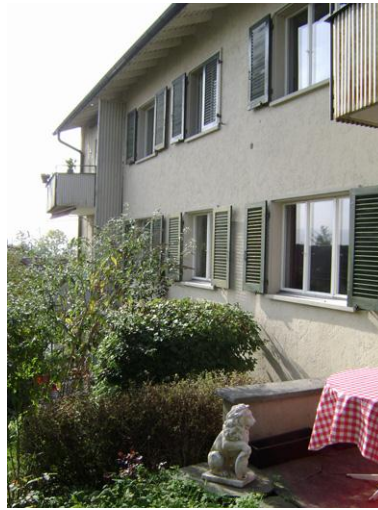
Fig. 2 Südostfassade vor Sanierung
