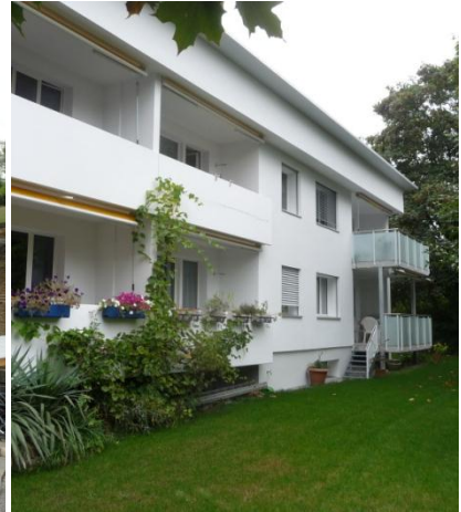
Fig. 10 Südwestfassade nach Sanierung
