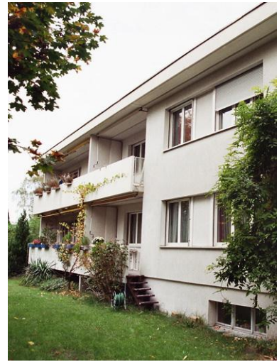
Fig. 3 Südwestfassade vor Sanierung
