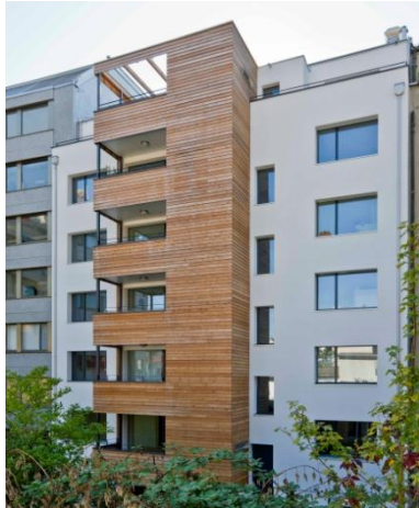
Fig. 8 Hoffassade nach Sanierung
