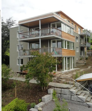
Fig. 9 Südwestfassade nach Sanierung
