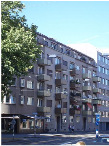
Fig. 1 Strassenfassade vor Sanierung
