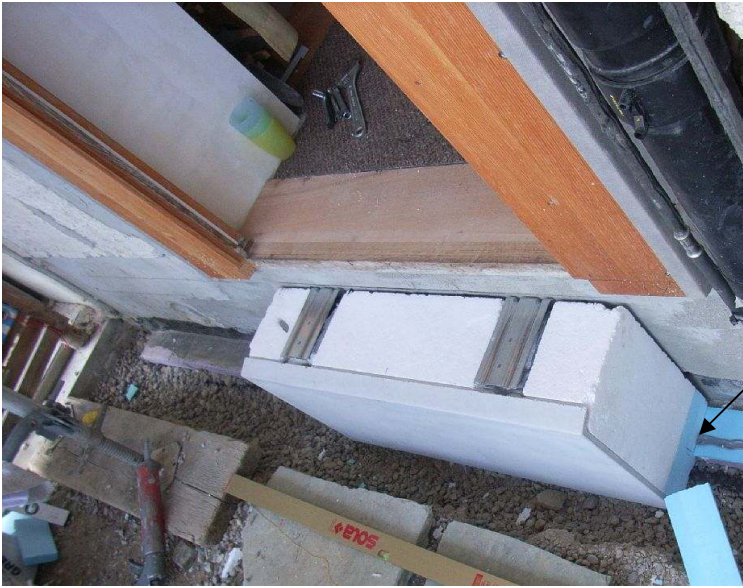
Abbildung 5-6: Sockelelement unter Türschwelle
