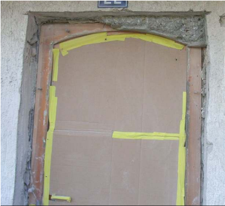
Abbildung 5-3: Der alte Türrahmen wird komplett freigelegt
