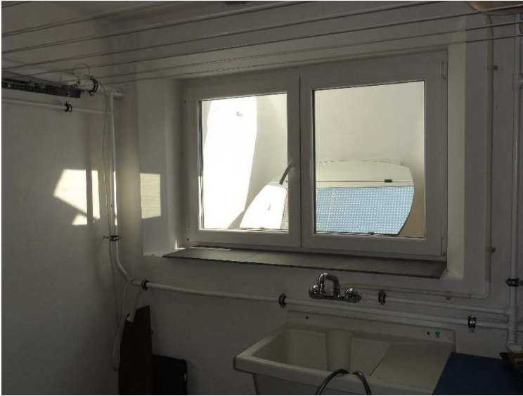
Abbildung 3-35: Innenaufnahme des neuen Lichtschachtes.
