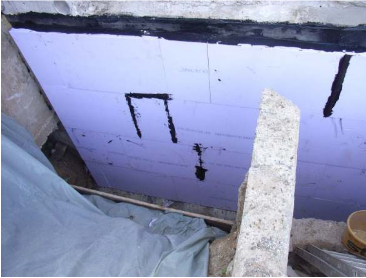
Abbildung 3-26: Perimeterdämmung
