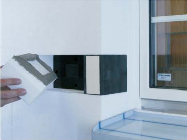
Abbildung 4-43: Schliessen der Isolation nach der Montage des Klobenelementes (Dosteba)
