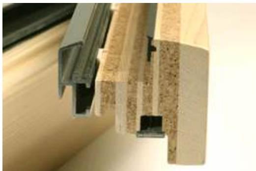
Abbildung 4-4: Fensterrahmen als Holz-Kork-Verbund noch vor dem Lackieren und vor dem Einsetzen der Verglasung (Frinorm)
