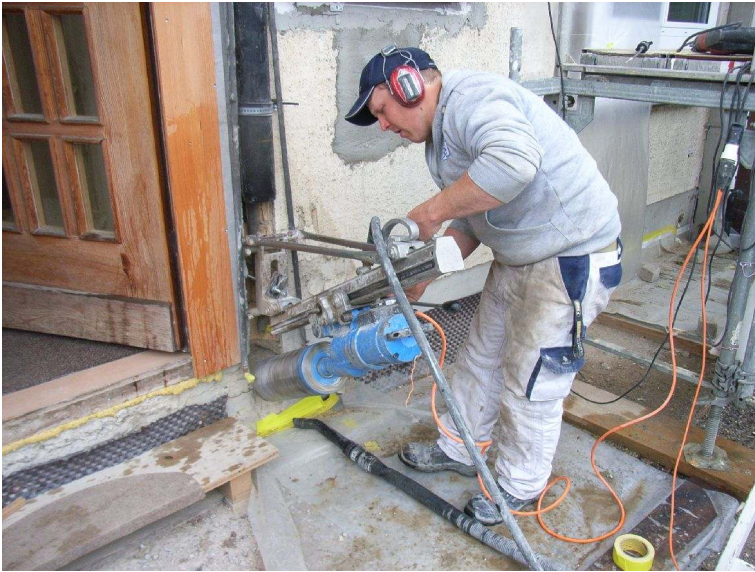
Abbildung 3-12: Kernbohrung im Sockel
