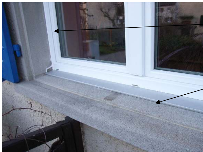
Abbildung 4-11 Beispiel eines "richtigen" Nur - Fensterersatzes:
