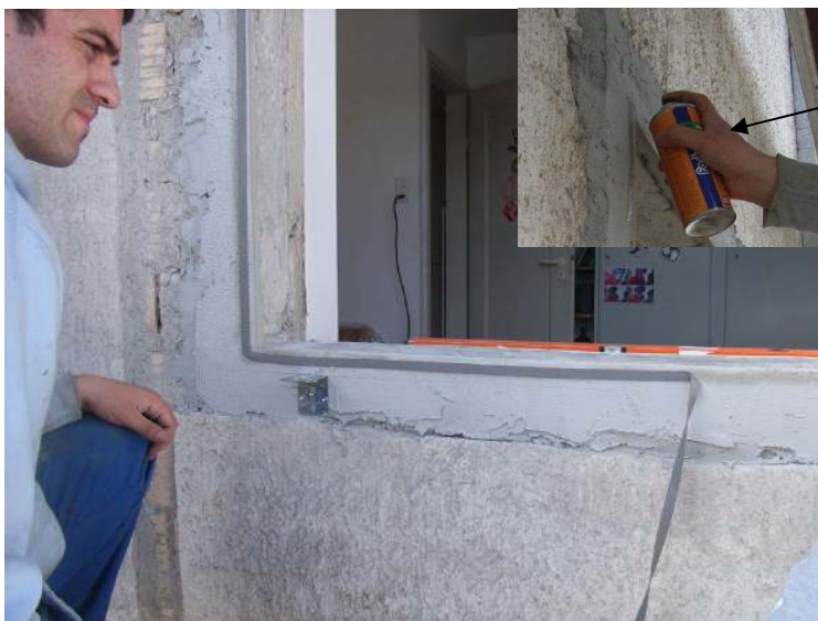
Abbildung 4-33: Anschlagputz und Dichtungsband
