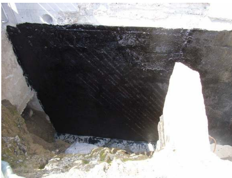
Abbildung 3-21: Wasserschutzanstrich der UG Mauer
