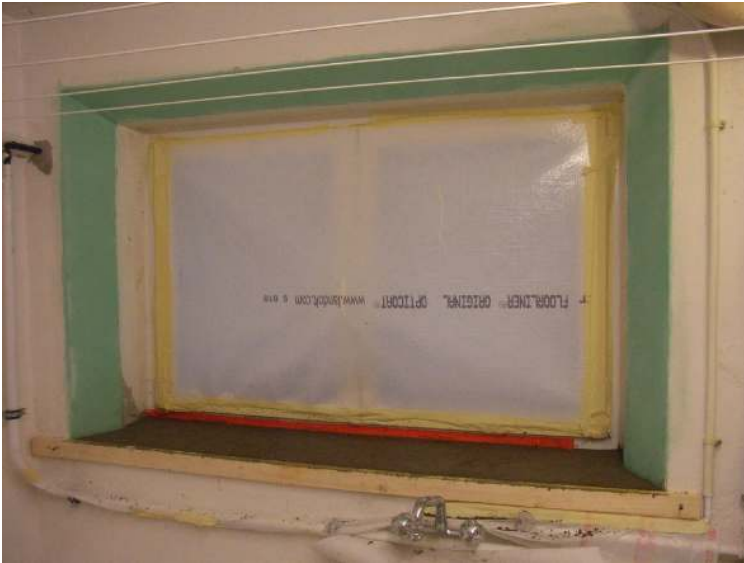
Abbildung 4-24: Neue Fensternische im Rohbau
