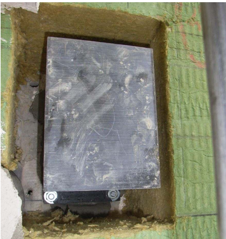
Abbildung 4-54: Schwerlastelement montiert.
