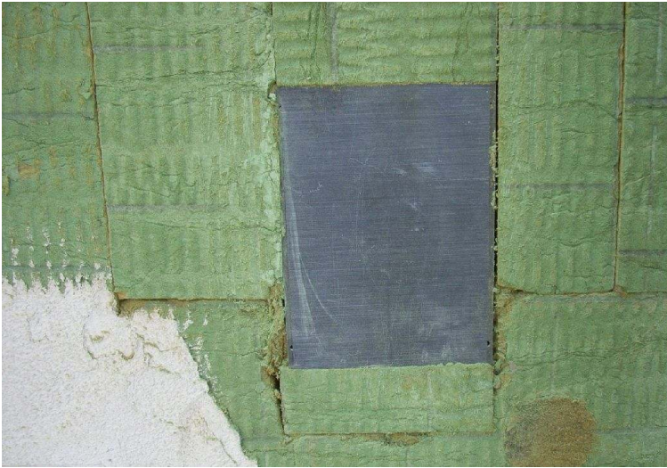
Abbildung 4-55: Fertig "eingepacktes" Schwerlastelement, bereit für den Verputz
