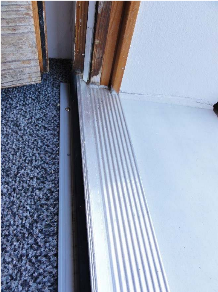
Abbildung 5-8: Schwellenprofil mit Gummidichtung
