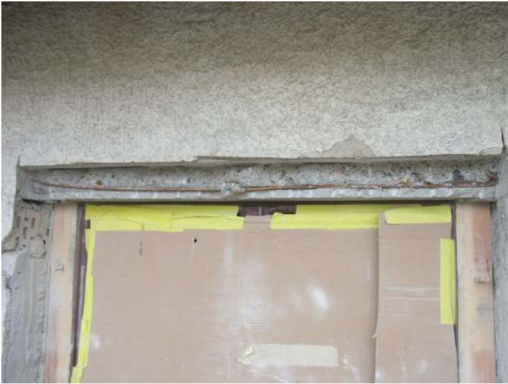
Abbildung 4-31: Sturzarmierung
