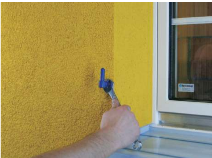
Abbildung 4-44: Befestigung des Klobens vor dem Einhängen der Klapppläden. (Dosteba)
