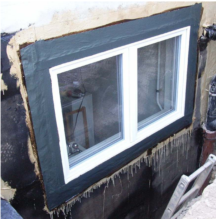
Abbildung 4-22: Das neue Fenster, Ansicht von aussen.
