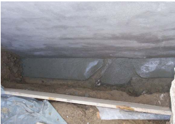
Abbildung 3-20: Einlaufbett für Sicker- leitung
