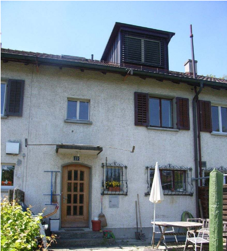
Abbildung 5-1: Vor der Fassadensanierung: Haustüre als prägendes Element
