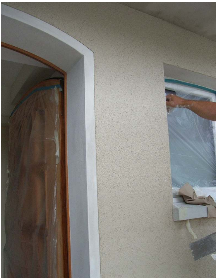
Abbildung 5-13: Edelputz im Leibung- und Sturzbereich.
