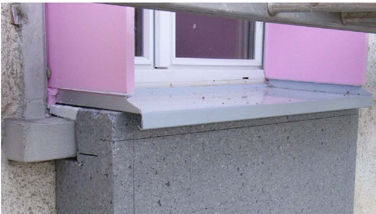
Abbildung 4-41: Fensterbankersatz durch Blech
