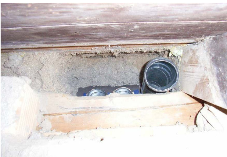
Abbildung 7-3: Dachrand nach Entfernung der Mauerausfachung.
