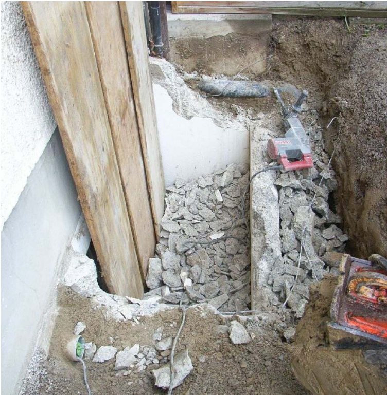
Abbildung 3-14: Abspitzen eines alten Lichtschachtes.
