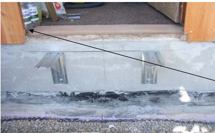
Abbildung 5-5: Haltewinkel für die neue Türschwelle:
