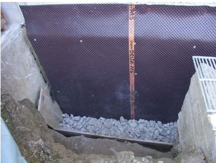
Abbildung 3-28: Auffüllen mit Betonbruch als Sickerschicht
