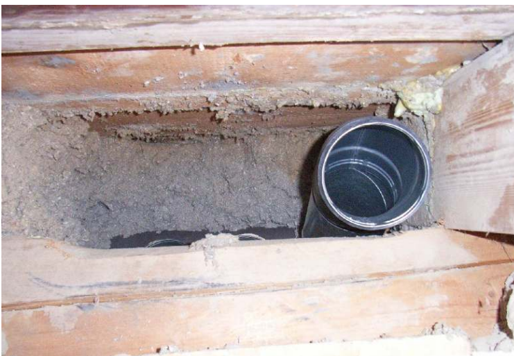
Abbildung 6-6: Einführung der Lüftungsleitungen in den Estrich.
