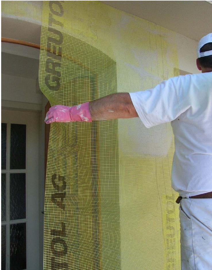
Abbildung 5-12: Gewebeamierung vollflächig im Grundputz eingearbeitet.
