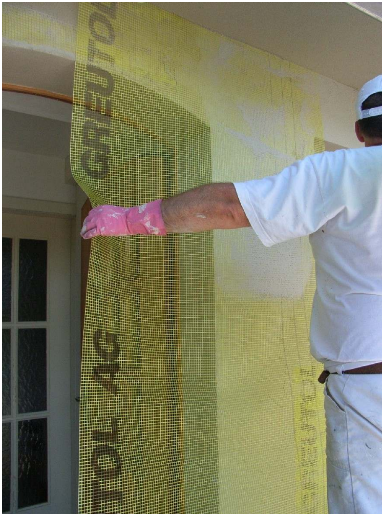
Abbildung 2-3: Armierungsgewebe wird in den Grundputz eingearbeitet.
