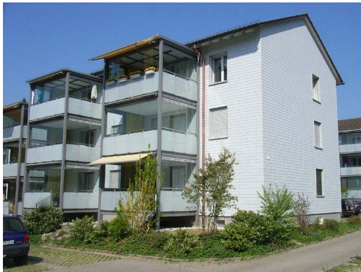
Abbildung 8-4: Grosse, separat abgestützte Balkone
