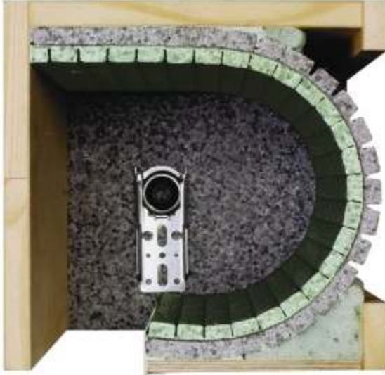
Abbildung 4-45: Sanierungssystem für innenliegende Rollladenkästen (unbekannt)
