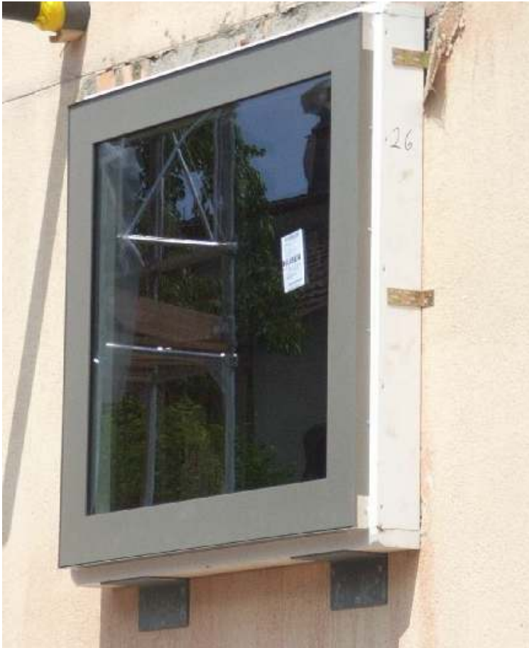
Abbildung 4-34: Fensteranschlag
