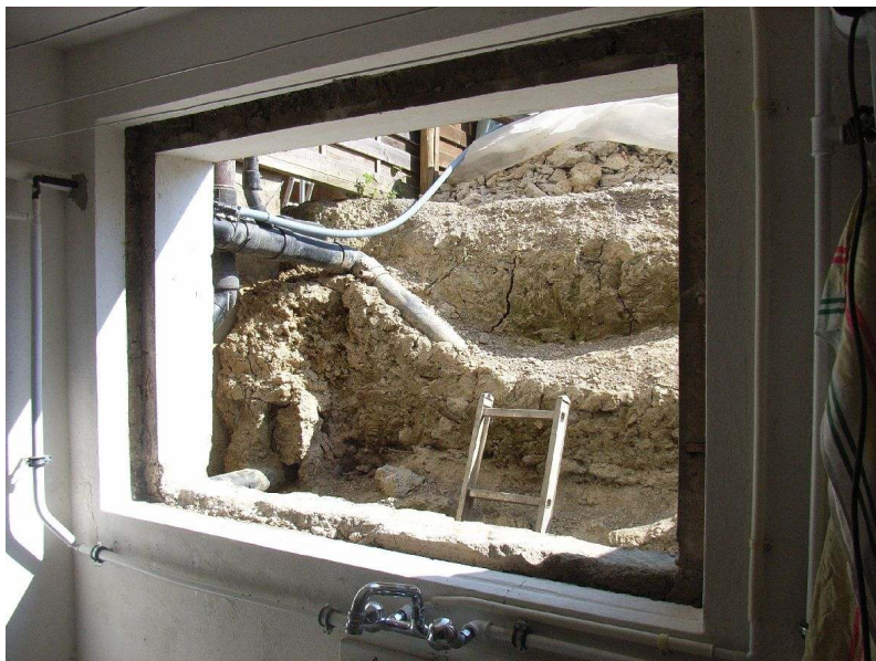
Abbildung 4-21: Altes Fenster demontiert, Ansicht von innen.
