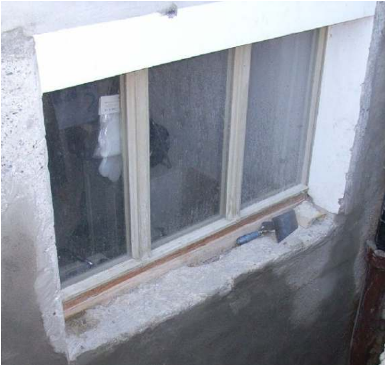
Abbildung 4-20: Das alte Fenster von aussen.
