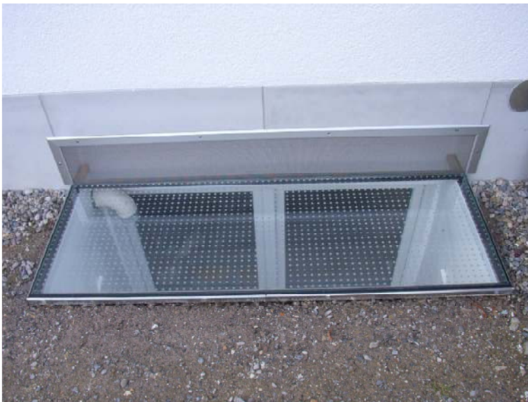
Abbildung 3-34: Lichtschacht fertig
