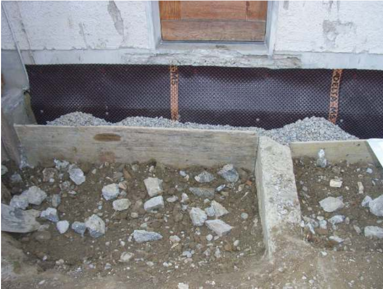
Abbildung 3-29: Auffüllen mit Geröll und Wandkies
