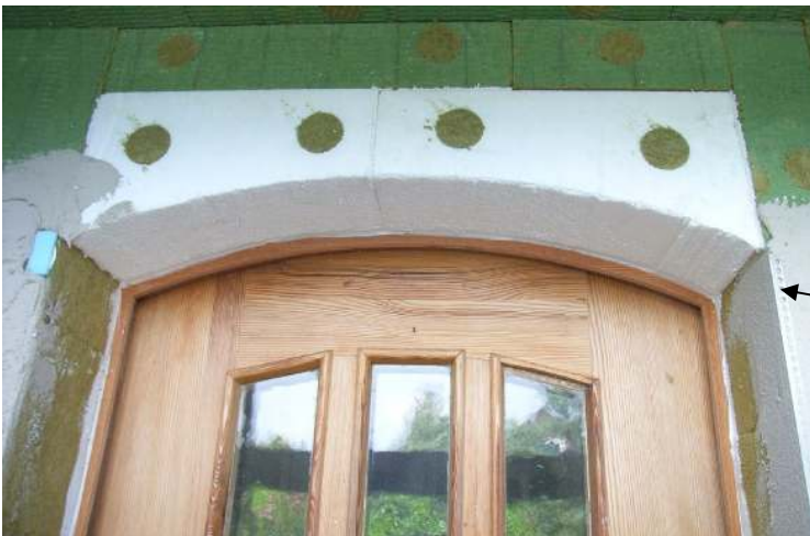
Abbildung 5-9: Runde Sturznachbildung aus Polystyrol
