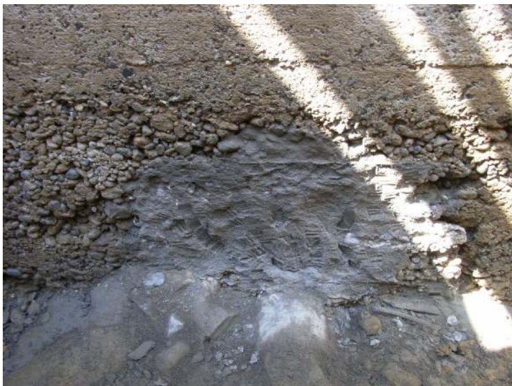
Abbildung 3-17: Abspitzen des "Einlauftrichters"
