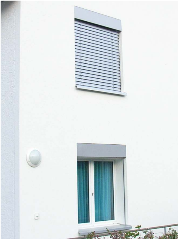
Abbildung 4-47: Integrierter Lamellenstoren
