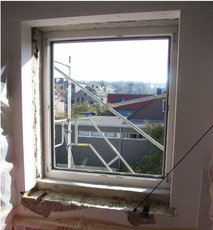
Abbildung 4-15: Fensternische 1 im "Rohbau"
