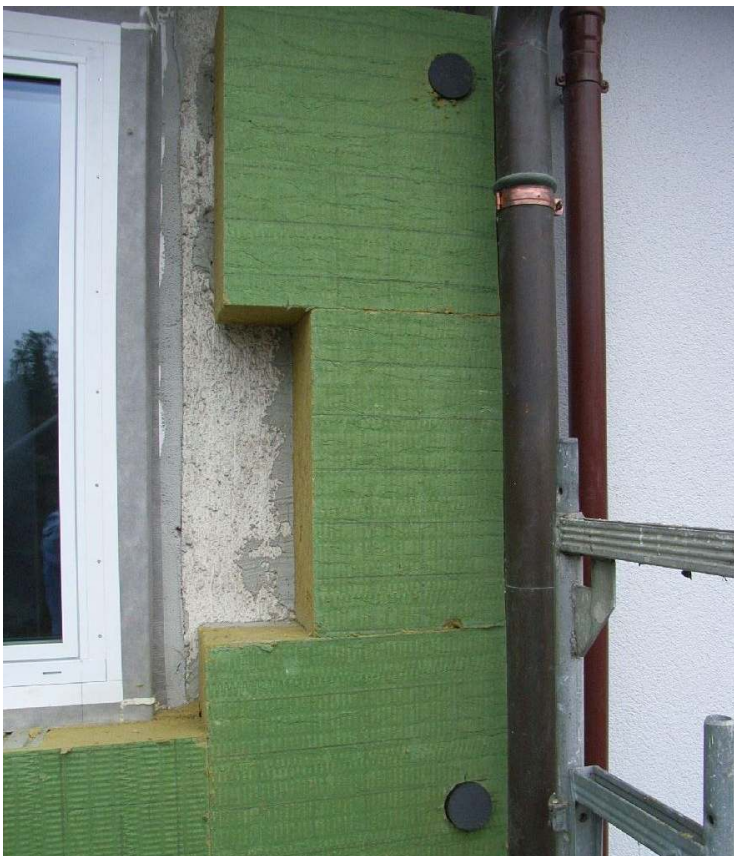
Abbildung 8-7: Befestigungsrondellen, eingelegt für zukünftige Abgasleitung.
