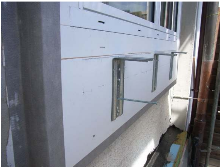
Abbildung 4-36: Montage der Haltewinkel für den Fensterbank
