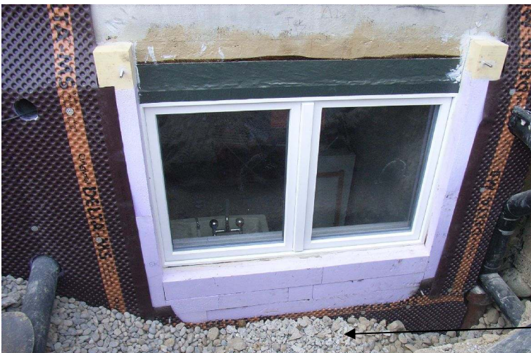
Abbildung 3-32: Kellerfenster vor der Montage des Lichtschachtes
