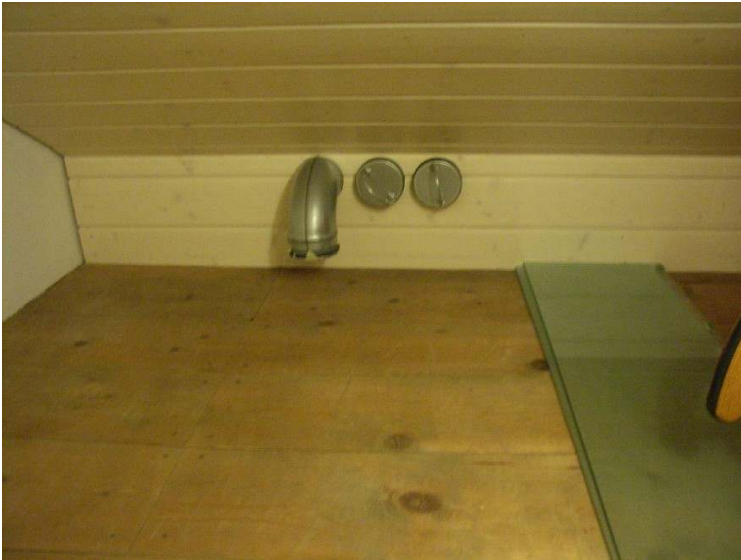
Abbildung 6-7: Einführung der Lüftungsleitungen in den Estrich, Blick von Innen.
