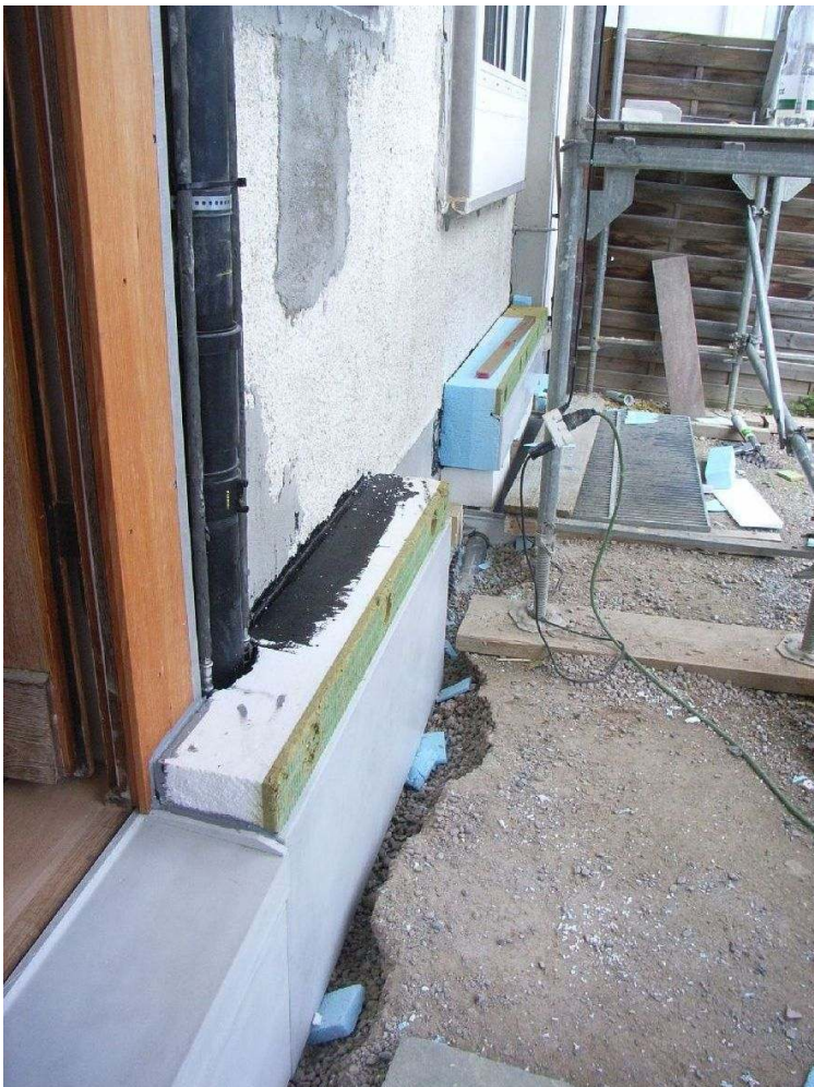
Abbildung 5-7: Türschwelle und anschließende Sockelelemente
