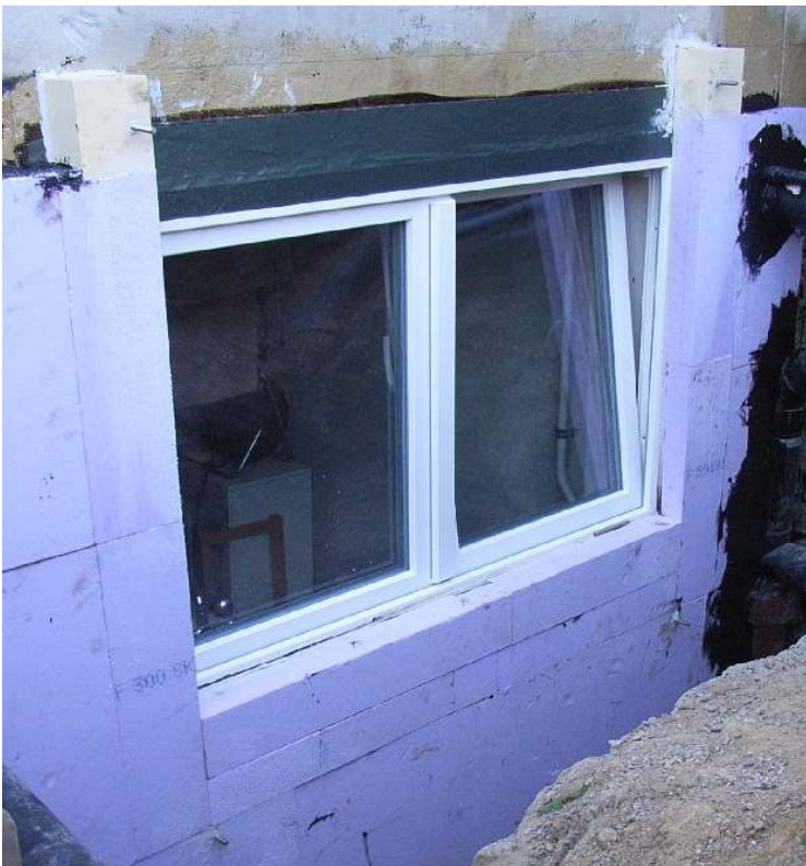
Abbildung 4-23: Überisolieren des neuen Fensterrahmens.
