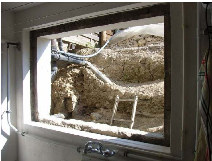
Abbildung 3-24: Blick in die "lehmige" Baugrube durch das bereits entfernte Kellerfenster (Waschküche).
