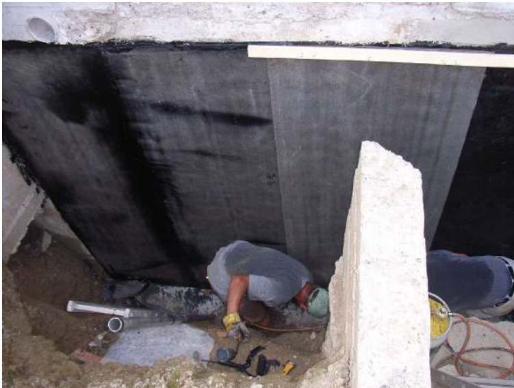
Abbildung 3-22: Anbringung einer zusätzlichen wasserdichten Schutzschicht auf den UG-Aussenmauern.
