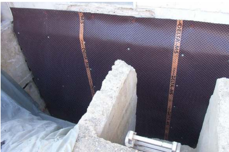
Abbildung 3-27: Noppenfolie als Drainageschicht und Schutz der Perimeterdämmung
