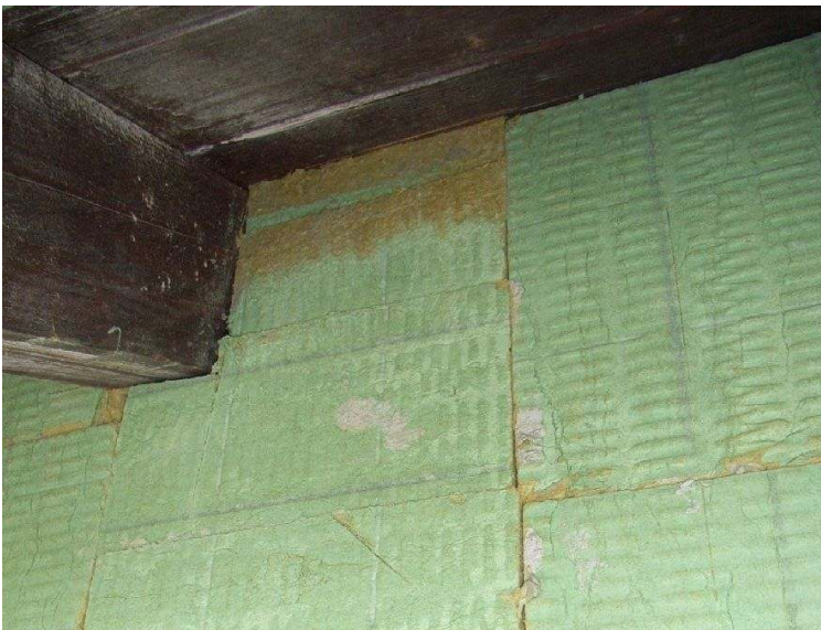
Abbildung 7-5: Fertig Wärmegegedämmter Dachrandanschluss
