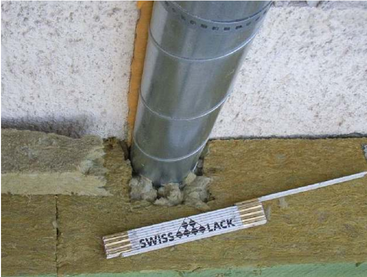
Abbildung 6-5: Dämmung der Lüftungsleitungen (2)
