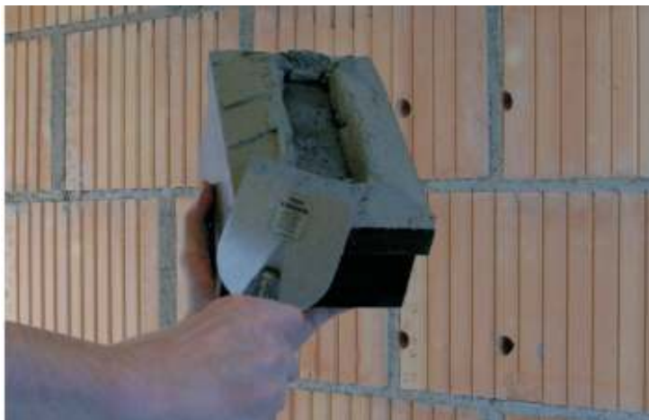
Abbildung 4-53: Klebemörtelbett für Schwerlastelement (Bild Dosteba)
