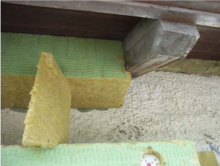
Abbildung 7-4: Wärmedämmung des Dachrandes
