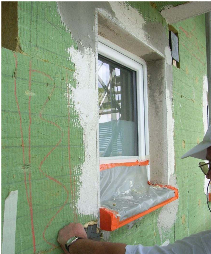
Abbildung 4-39: Fensternische aus Fassadenisolation
