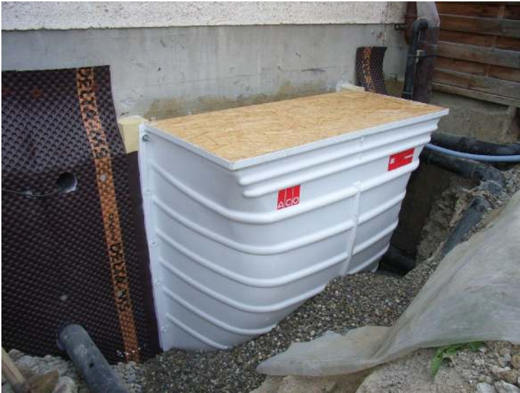
Abbildung 3-33: Kunststofflichtschacht montiert
