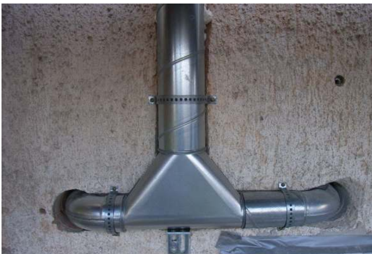
Abbildung 6-1: Lüftungsleitungen
