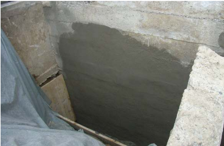
Abbildung 3-19: Verspachtelte, sanier- te UG-Aussenmauer
