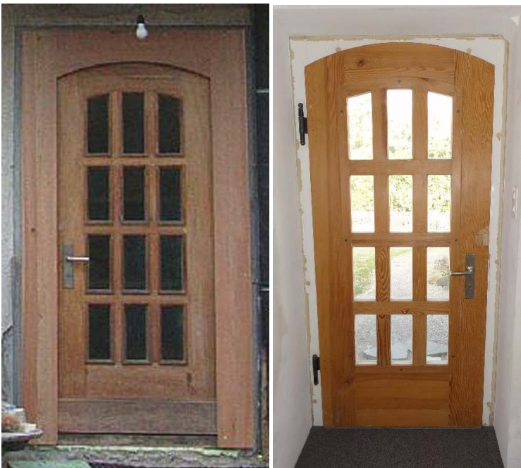
Abbildung 5-4: Neuer Türrahmen, außen angeschlagen(links)
