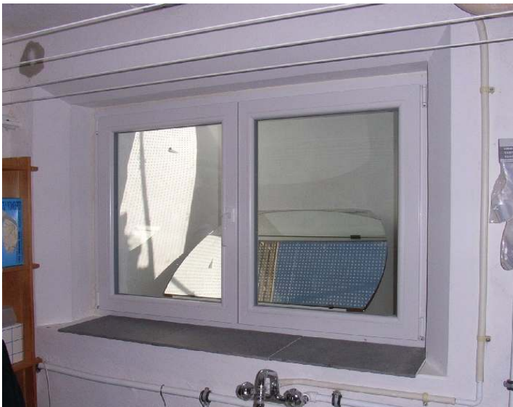
Abbildung 4-25: Das fertige neue Fenster
