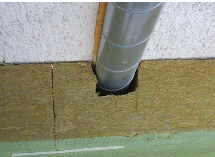
Abbildung 6-4: Dämmung der Lüftungsleitungen (2)
