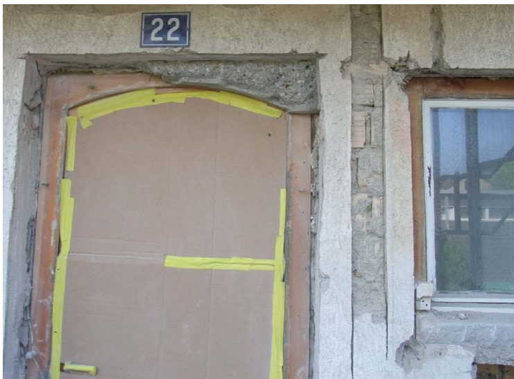
Abbildung 4-32: Erweiterte Mauernischen
