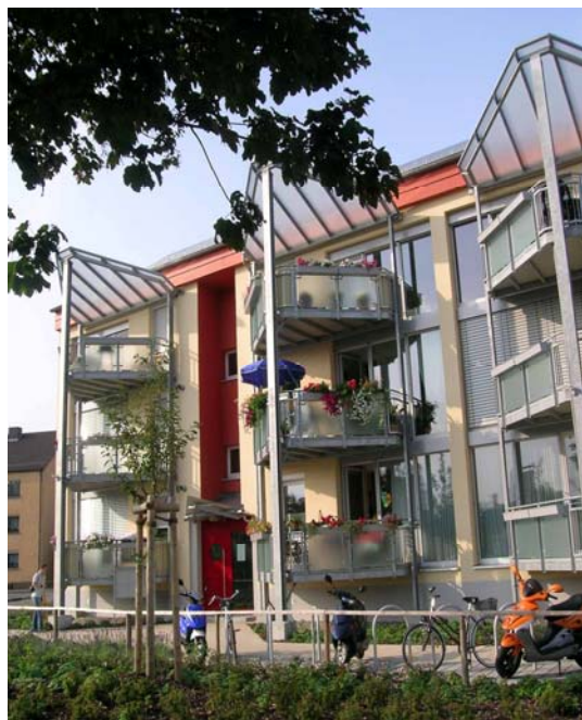
Abb. 6: Projekt "550 APT Ludwigshafen DE" Die alten Balkone wurden entfernt und neue, grössere Balkone gebaut. Quelle: AEU
