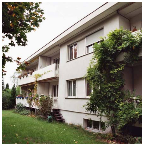
Fig. 5: Typ 3: Mehrfamilienhaus Volketswil vor der Erneuerung auf Minergie® (Kämpfen)
