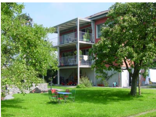
Fig. 1a: Sanierung eines Zweifamilienhauses in Stansstad, CH (Quelle: Architekt BARBOS, CH-6370 Stans)
