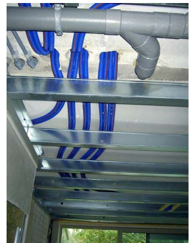
Fig. 1: Passive renovation Pendrecht, Rotterdam, NL (Quelle: Chiel Boonstra, DHV)
