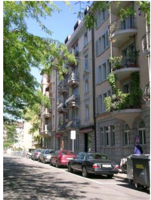
Fig. 2: Wohnbausanierung Wengistrasse 6, Zürich (Quelle: D. Enz, AEU GmbH, Wallisellen)
