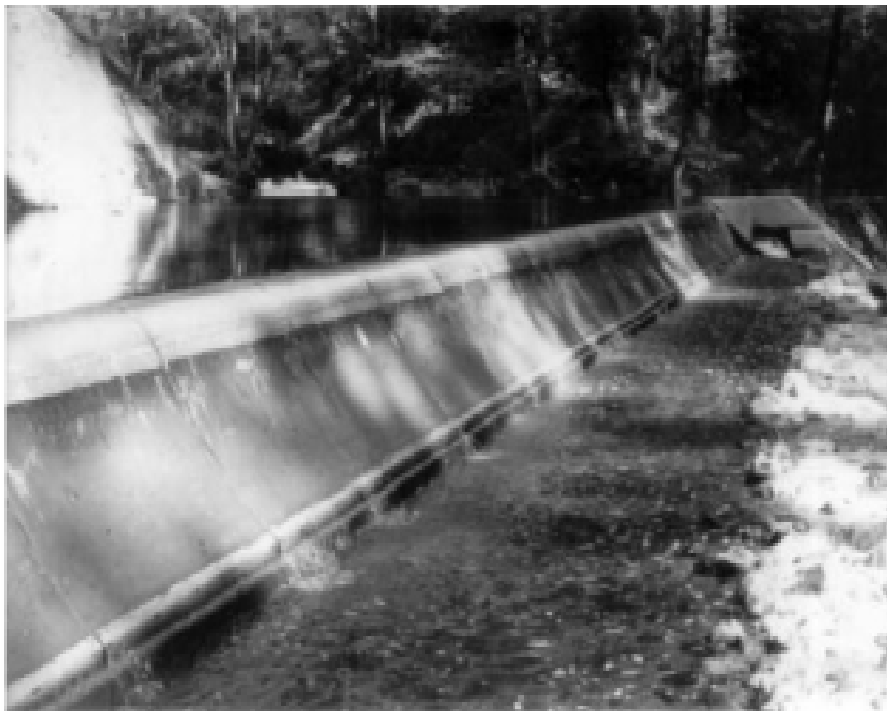
Photo 4. Exemple de prise d'eau Coanda
