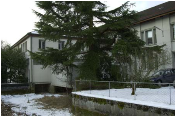
Photo 3. Entrée de l'ancienne centrale
