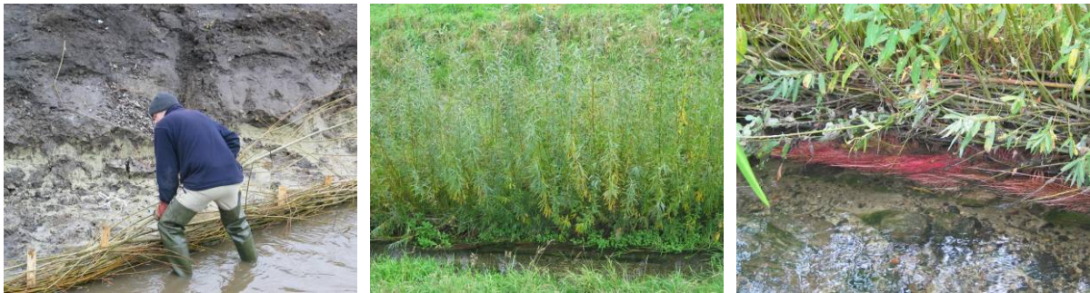
Photo 11. Tressage pour la protection du pied de berge (résultats après une période de végétation et détails).
