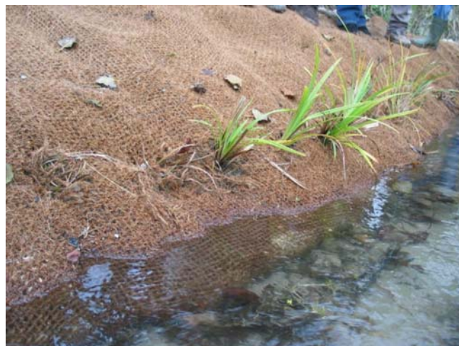
Photo 10. Mottes d'hélophytes intégrées dans une berge renforcée avec un treillis de coco (état juste après la mise en place).
