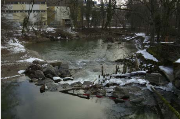
Photo 1. Seuil et passe à poissons sur la Venoge
