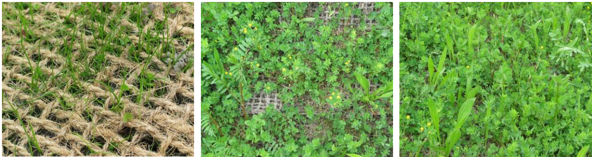
Photo 9. Évolution d'un ensemencement à travers un géotextile tissé, biodégradable.
