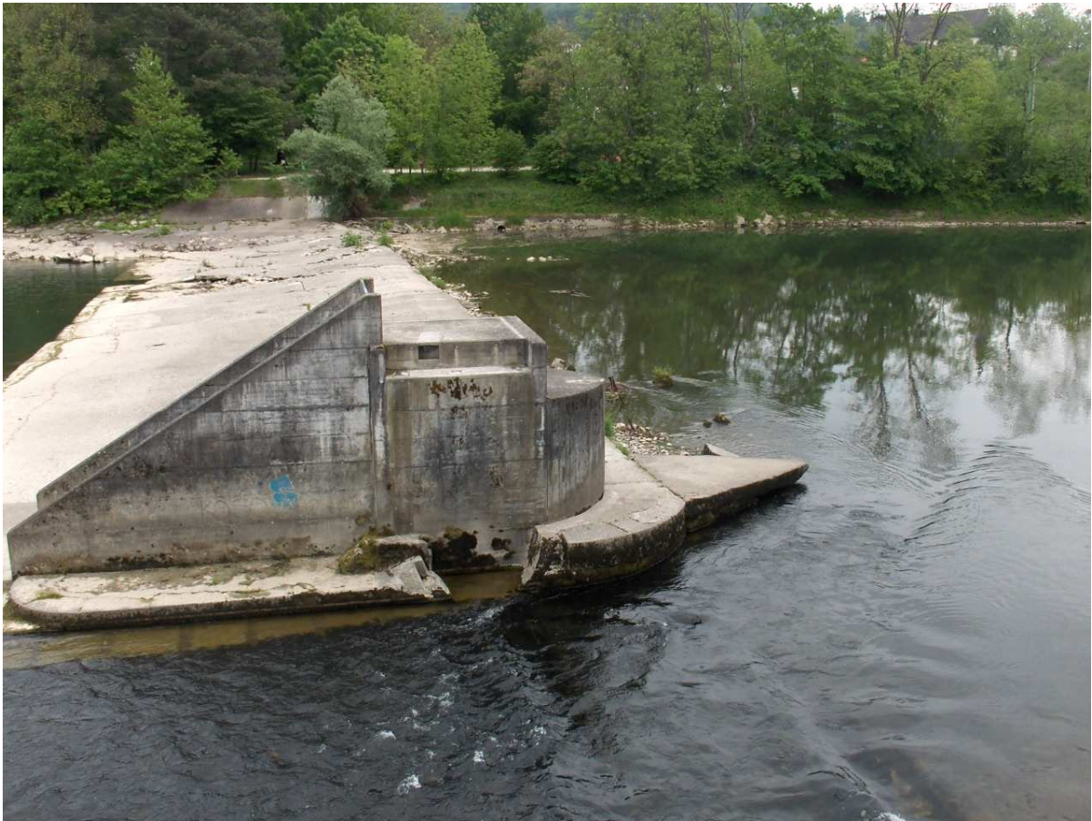
Abbildung 1:: Bestehende Bally-Schwelle mit Wehrfeld des ehemaligen Walzenwehres im Vordergrund
