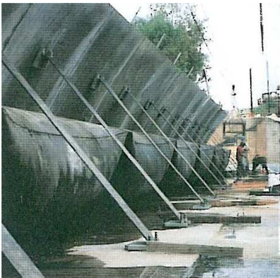
Abbildung 7: Vorgeschlagene Stausysteme: Schlauchwehr oben und System Obermeyer unten, welches konventionelle Stauklappen mittels Luftkissen hebt.
