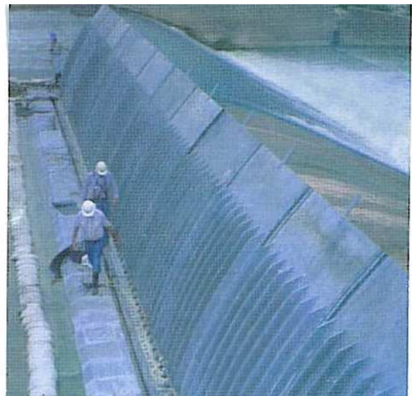
Abbildung 7: Vorgeschlagene Stausysteme: Schlauchwehr oben und System Obermeyer unten, welches konventionelle Stauklappen mittels Luftkissen hebt.
