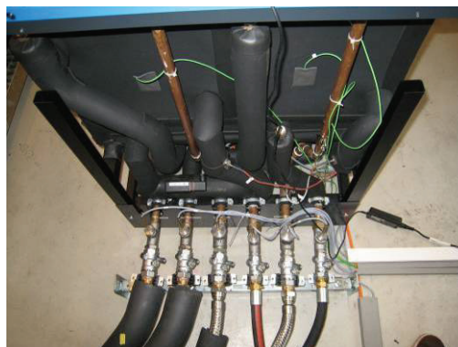
FIGURE 7 : RACCORDEMENT DES CIRCUITS A LA MACHINE SORTECH
