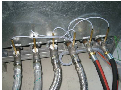
FIGURE 5 : RACCORDEMENT DES CIRCUITS A LA MACHINE SORTECH (DE GAUCHE A DROITE : HT; MT; LT) AVEC LES SONDAS DE TEMPERATURE PERMETTANT DE FAIRE LES BILANS D'ENERGIE
