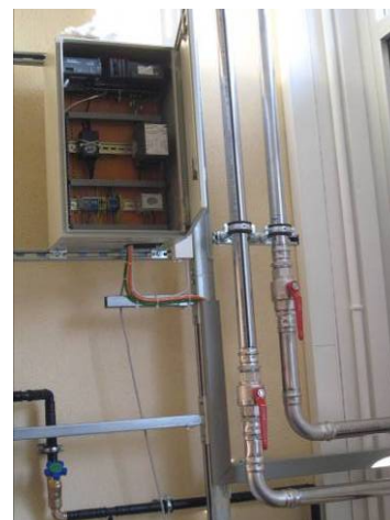
FIGURE 26 : ALIMENTATION DU RECOOLER DANS LE LOCAL S133 ET TABLEAU D'ACQUISITION DES SONDES SITUÉES À L'EXTÉRIEUR
