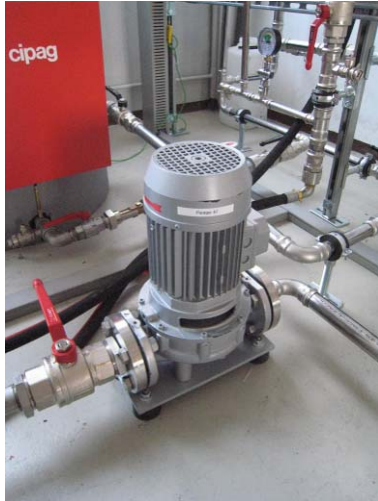
FIGURE 21 : CIRCULATEUR DU CIRCUIT MT
