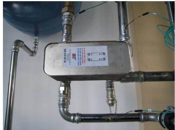
FIGURE 22 : ECHANGEUR A PLAQUES DU CIRCUIT RECOOLER
