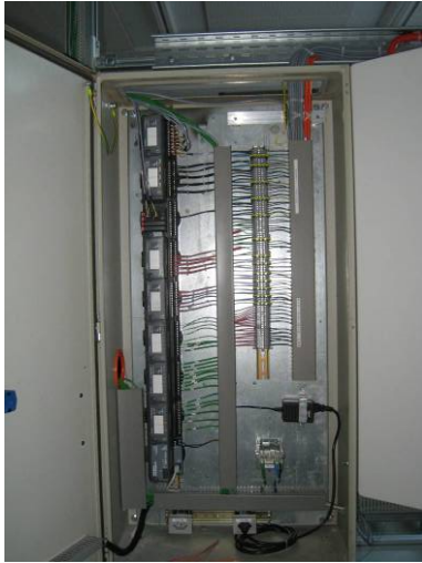
FIGURE 35 : TABLEAU PRINCIPAL D'ACQUISITION SITUE EN S02
