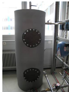
FIGURE 17 : CUVE DE STOCKAGE, 300 LITRES
