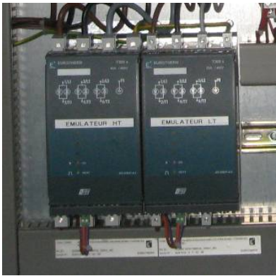
FIGURE 20 : THYRISTORS PERMETTANT DE REGULER LA TEMPERATURE DE SORTIE DU CORPS DE CHAUFFE
