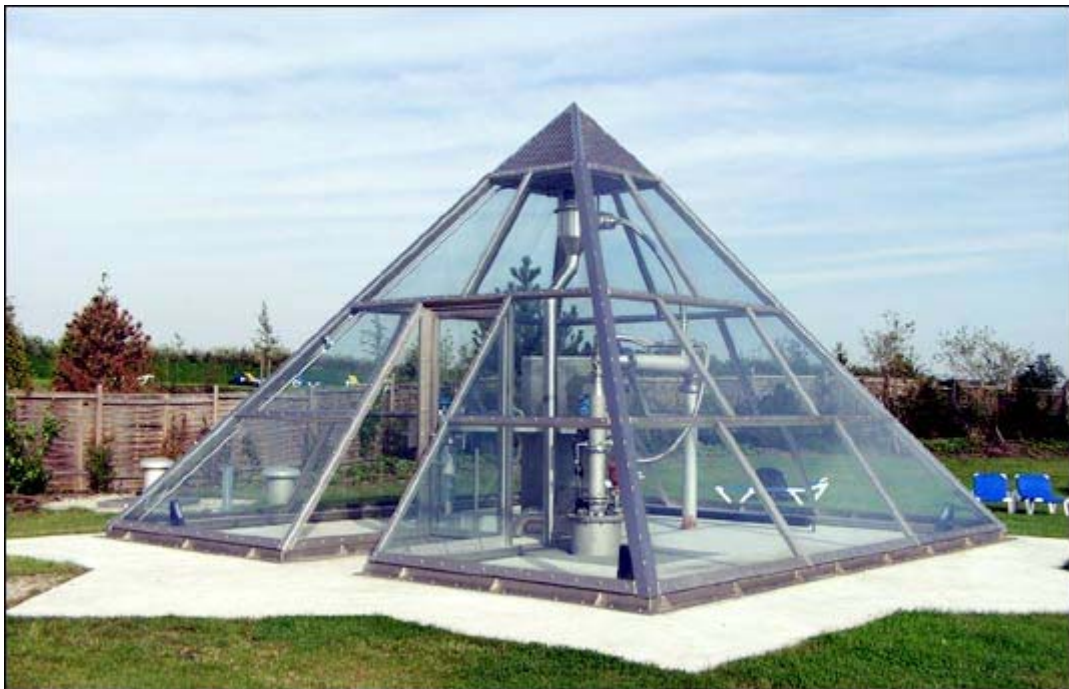
Tête du forage de Erding (Allemagne) Profondeur 2'359 m, débit 24 l/s à 62°C
