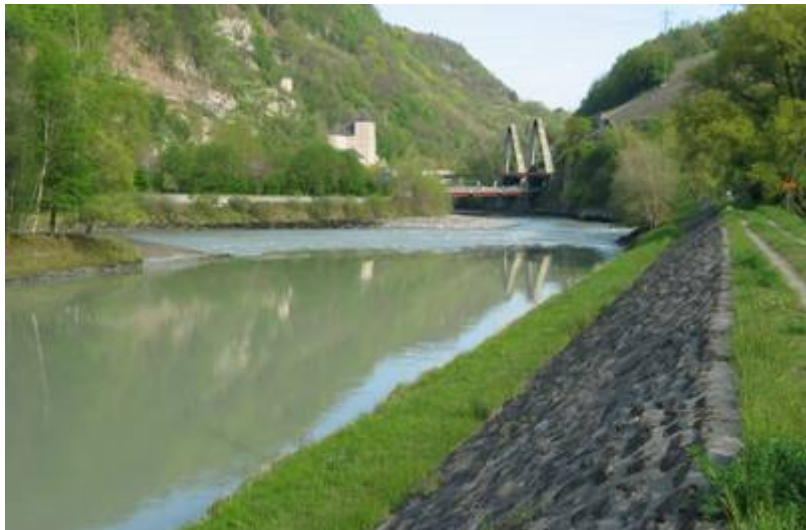
Figure 2.8 : Embouchure du canal de fuite de l'usine de Lavey dans le Rhône (Q min. : 40 \text{ m}^3/\text{s} ).
