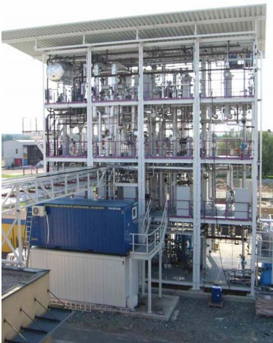
Abbildung 3 1 MW SNG -Pilotanlage für die Erzeugung von Erdgassubstitut (SNG) in Güssing
