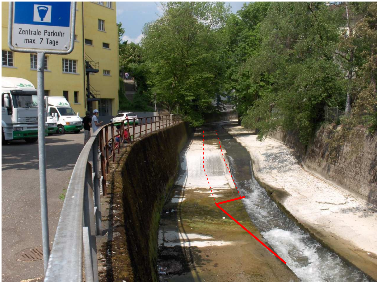
Abbildung 6:: Vorgesehene Rückgabe des Wassers am Ende des 85m langen Unterwasserkanals
