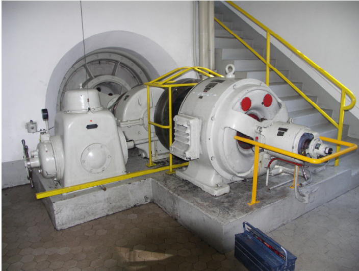
Bild 5: Generator mit Getriebe und Regler
