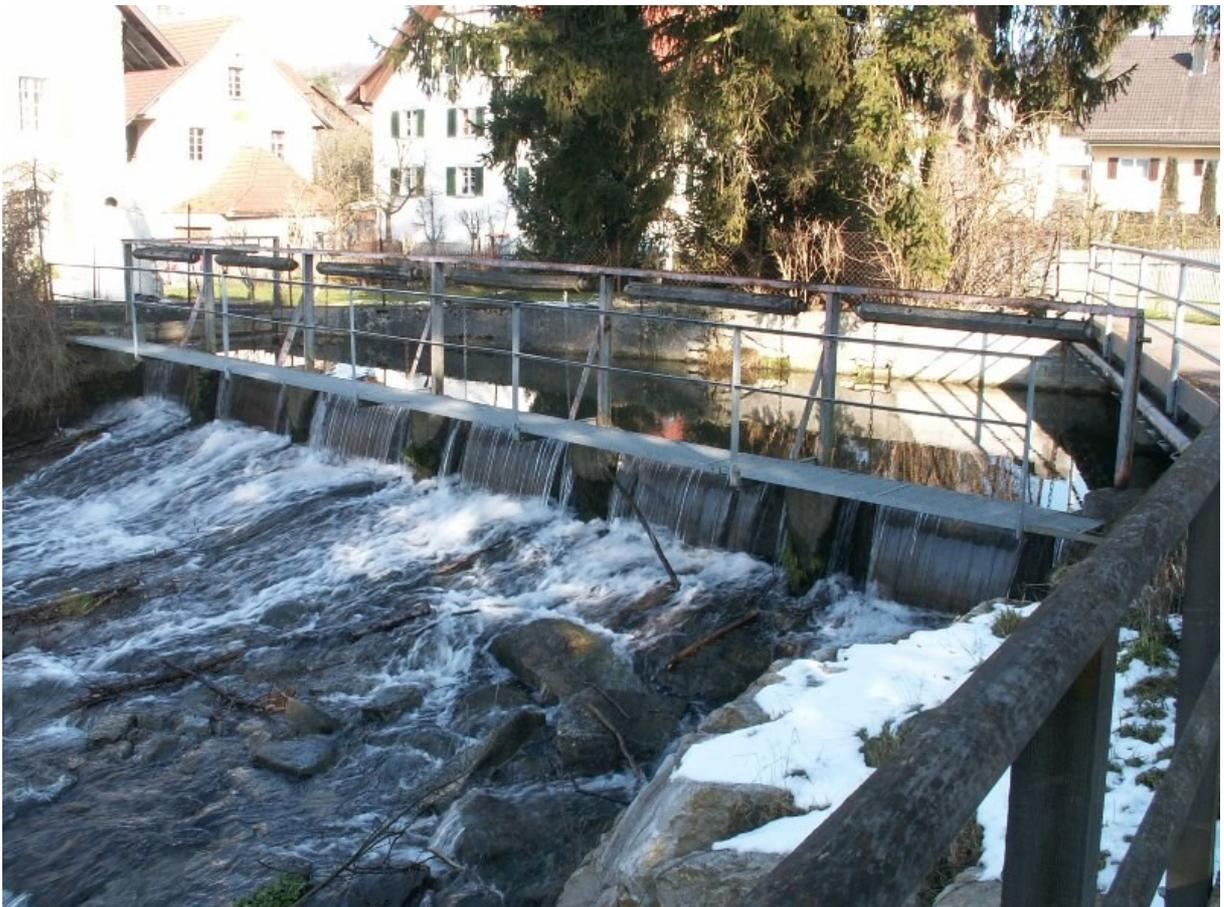
Abbildung 4.: Ansicht der Wehranlage mit 6 Wehrfeldern und Bediensteg
