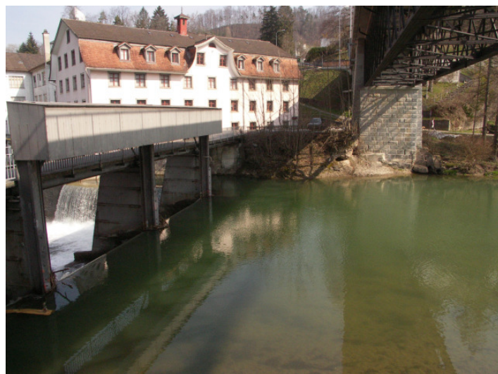
Bild 3: Bestehende Wehranlage / Schleusenbrücke Oberwasser Blickrichtung Lichtensteig
