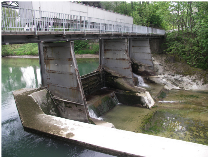
Bild 5: Bestehende Wehranlage / Schleusenbrücke Unterwasser Blickrichtung Wattwil
