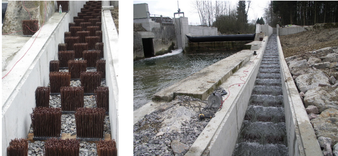
Abbildung 4: Borstenfischpass mit und ohne Wasser / Anlage Murkart – Frauenfeld / April 2008
