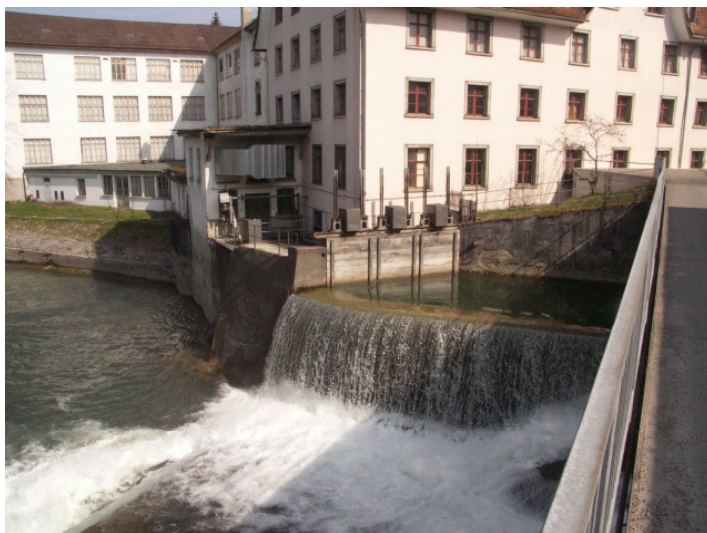
Bild 2: Bestehende Wasserkraftanlage mit Zulaufkanal
