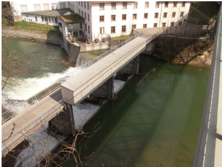
Bild 1: Übersicht bestehende Wasserkraftanlage mit Wehr und Zufahrtsbrücke
