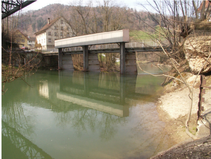
Bild 4: Bestehende Wehranlage / Schleusenbrücke Oberwasser Blickrichtung Wattwil
