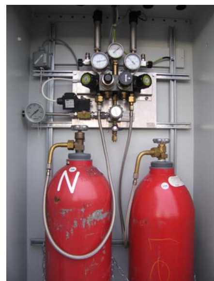
Abbildung 10: Wasserstoffversorgung mit Umschaltstation
