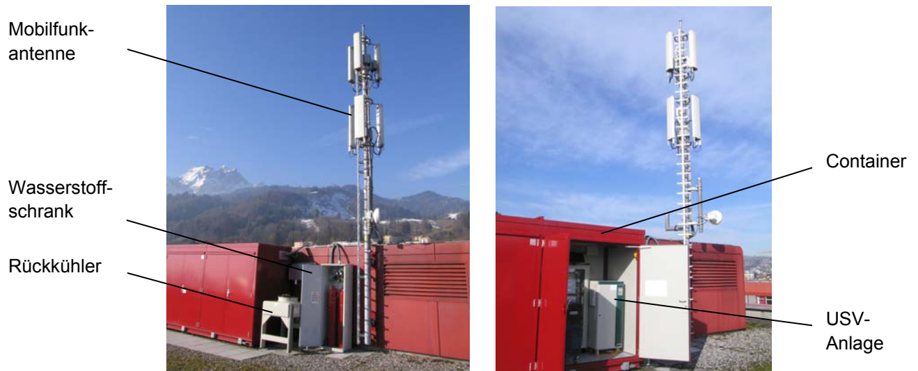
Abbildung 4: Aufstellung vor Ort mit Mobilfunkantenne
