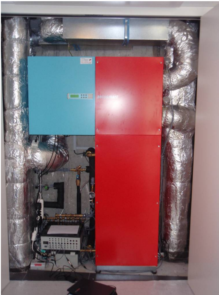
Abbildung 7.3 Kompaktgerät Aerosmart M
