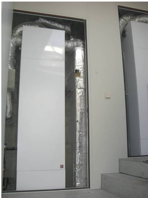
Abbildung 5.4 Einbauschacht mit Kompaktgerät Nilan VP18-10P
