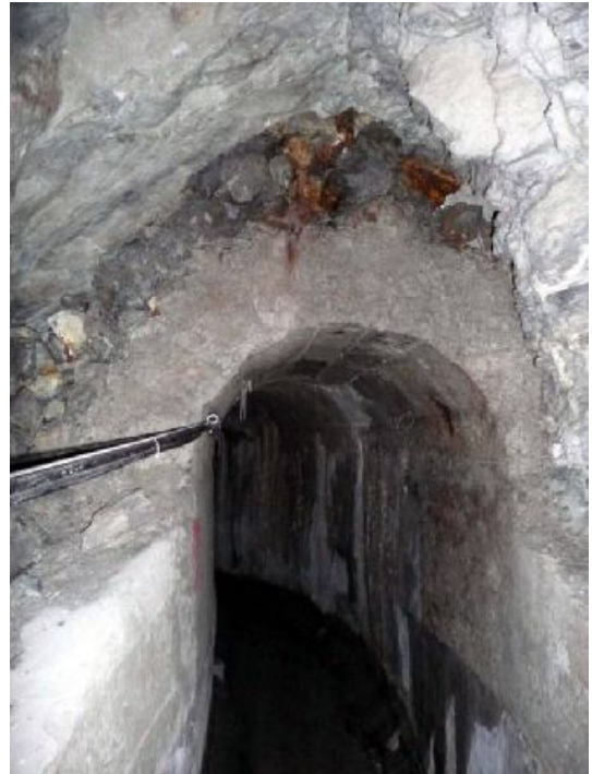
Photo 0.2 : Exemple de secteur conforté
