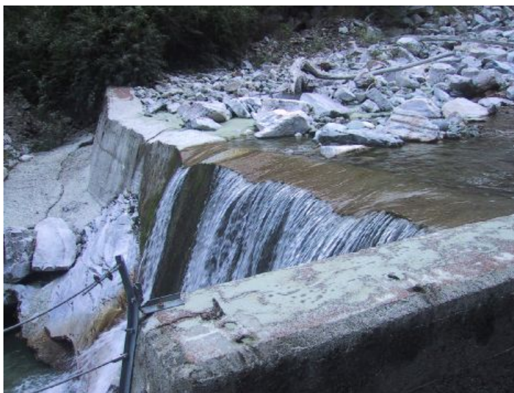
Photo 0.1 : Déversoir existant de l'ouvrage de prise
