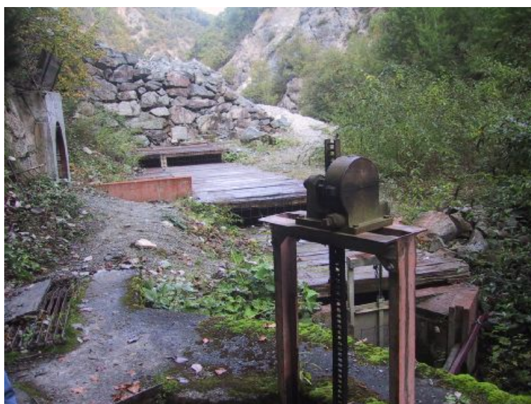
Photo 0.3 : Dessableur existant (sous le couvert de planches)
