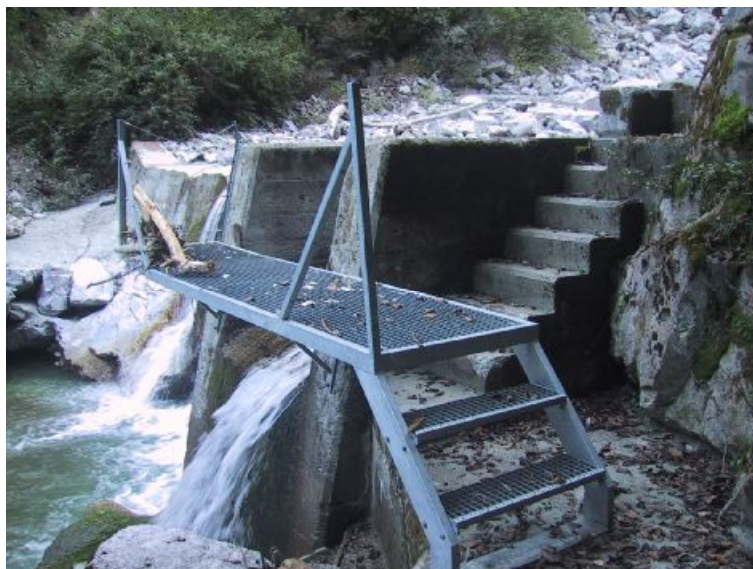
Photo 0.2 : Prise d'eau latérale, existante
