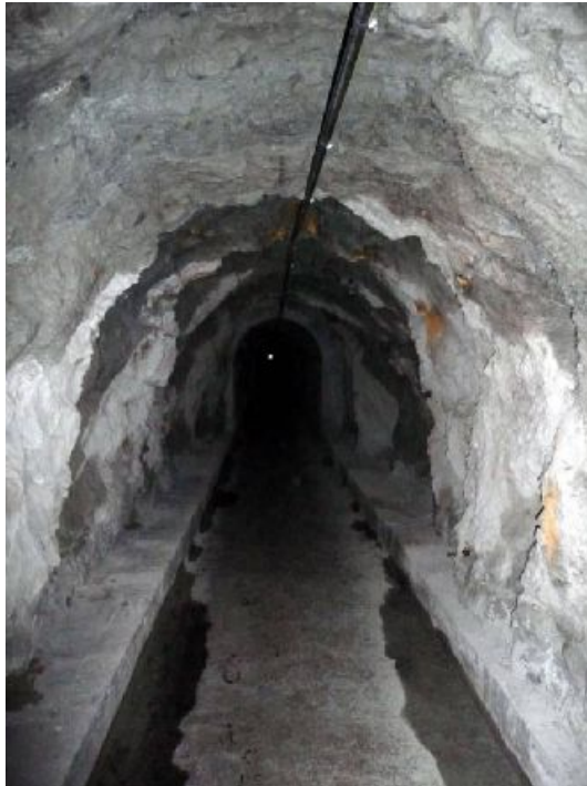
Photo 0.1 : Etat général de la galerie
