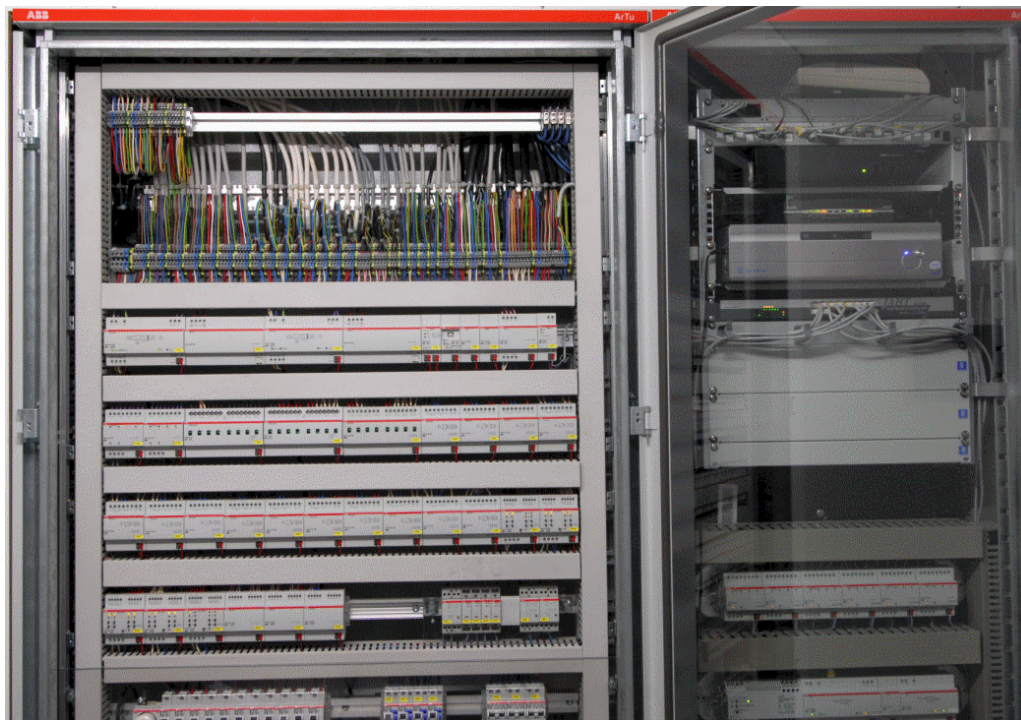
Bild 2-5 Die Hauptverteilung, links mit den KNX-Komponenten und rechts mit dem Multimediaeteil. (Quelle: ABB Schweiz AG Normelec)
