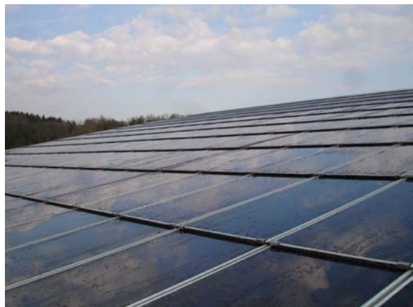
Abbildung 23 – Die vollflächig verlegten PV-Panelen dienen auch als Witterungsschutz
