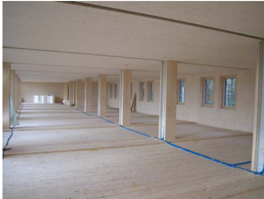
Abbildung 16 – Blick während der Bauphase in ein Geschoss: Die Stützen dienen als „Steigzonen“.
