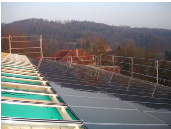
Abbildung 22 – Die Schienen der PV-Panelen wurden direkt auf der Dachkonstruktion befestigt
