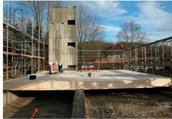
Erdregister: Zuluft fliesst durch Betonfundament
