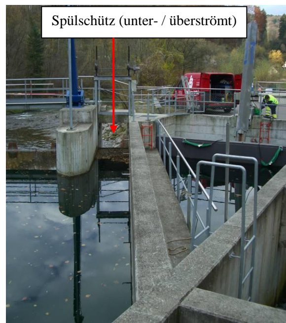
Fig. 4 Spülschütz im KWKW Freienstein
