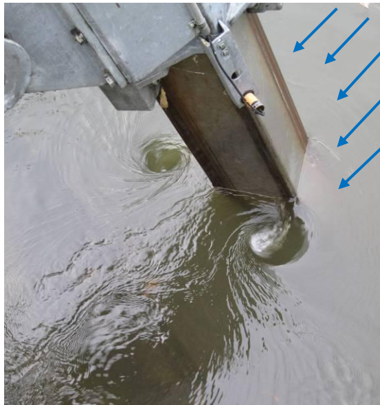
Fig. 55 Wirbelbildungen an Rechenführungsstange
