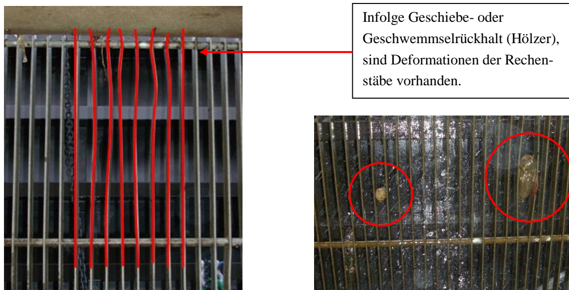
Fig. 7 Deformation der Rechenstäbe infolge Feststoffrückhalt im KWKW Freienstein
