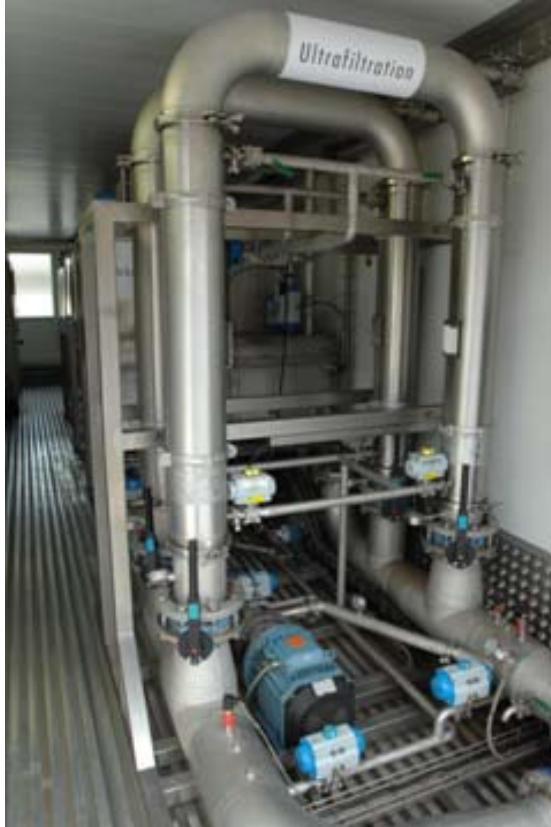
Abbildung 14: Ultrafiltrationsanlage zur Konzentrierung von separierter Schweinedünngülle. Die Anlage ist in einem Container untergebracht und weist eine Jahresleistung von ungefähr 4000 m 3 UF-Permeat/a auf (etwa 5000 m 3 Rohgülle/a)
