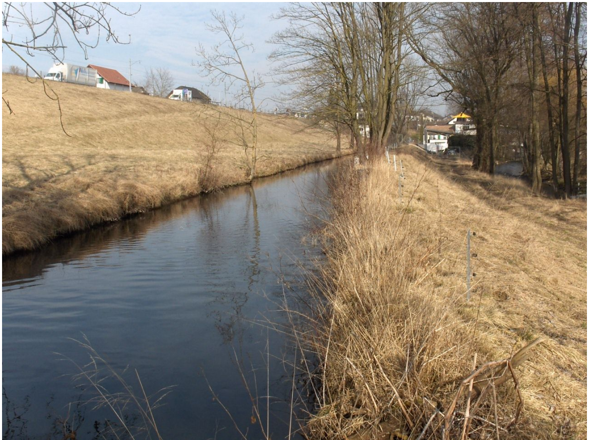
Abb. 2: Oberwasserkanal mit Dammbedingung rechtsufrig
