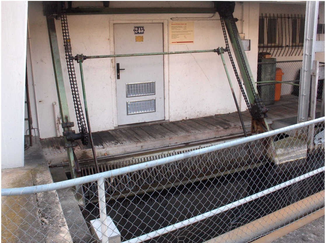
Abb. 3: Bestehender Rechen mit Rechenreinigungsmaschine, rechts noch knapp sichtbar die automatische Leerschussschütze
