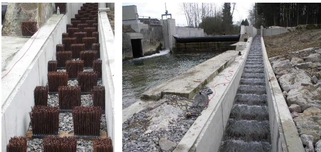
Abbildung 6: Borstenfischpass mit und ohne Wasser / Anlage Murkart – Frauenfeld / April 2008
