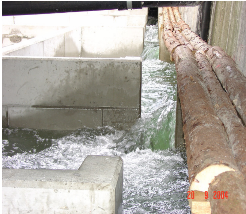
Abbildung 7: Einfache Gestaltung einer Biberpassage. Bsp. KW Augst
