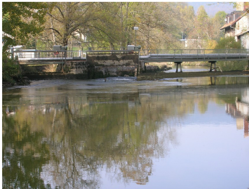
Figure 4. Vue de l'amont des deux vannes motorisées, de l'îlot de verdure, du seuil et de la passerelle
