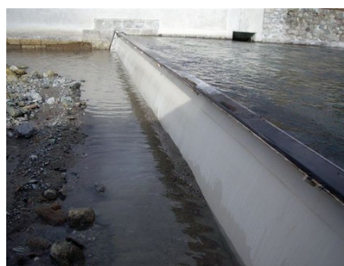
Figure 32. Exemple de vanne clapet
