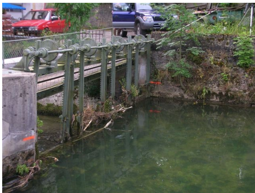
Figure 5. Vue de l'amont des vannes d'entrée du canal de la centrale
