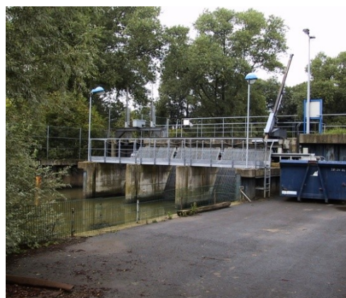
Figure 30. Exemple de grilles et de dégrilleur
