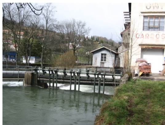
Figure 25. Vannes à démolir
