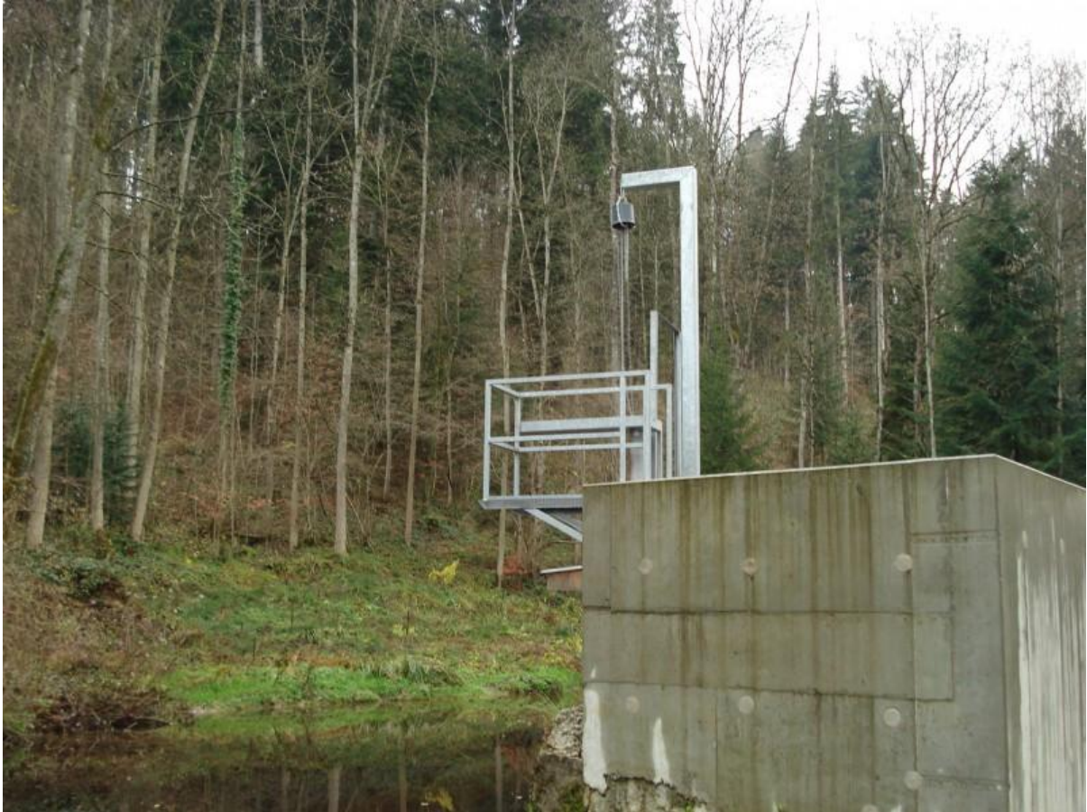
Figur 4: Kran für das Heben der an der oberen Schleusenöffnung angebrachten Kontrollreuse.
