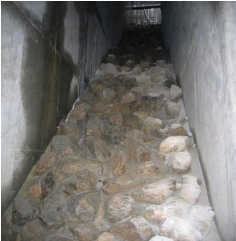
Figur 2: Mit einbetonierten Bollensteinen aufgeraute Schleusensole.
