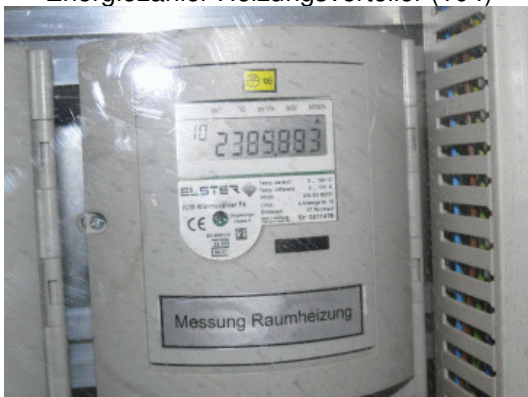
Energiezähler Heizungsverteiler (104)
