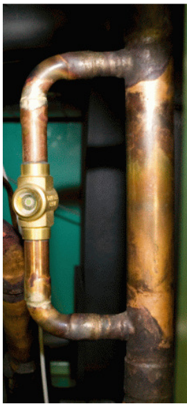
Figur 42: Schauglas nach dem Kältemittelunterkühler und vor der Drossel.
