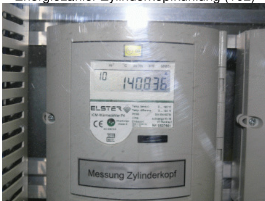
Energiezähler Heizungsverteiler (104)
