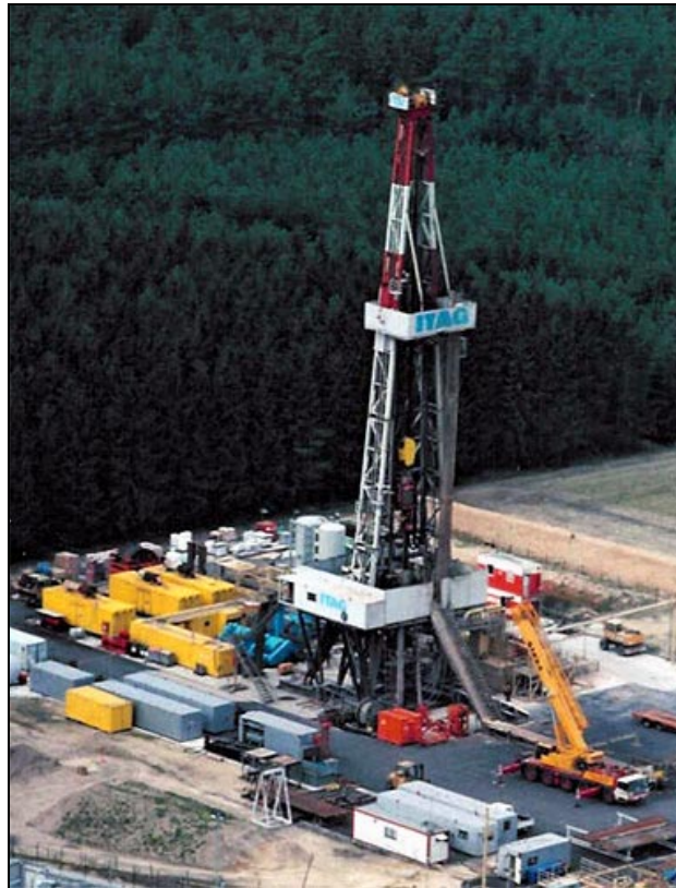
Fig. 30: Bohranlage der Firma ITAG – Rig 23- mit 460 to Lastaufnahme am Topdrive
