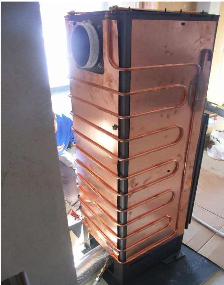
Abbildung 3-14: Der Kern des Absorber-Speicherofens beim Platzieren und Anschliessen - Ansicht von hinten
