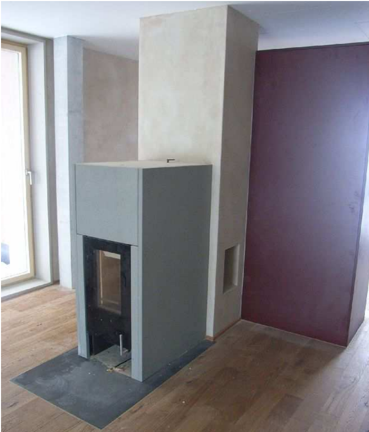
Abbildung 3-15: Fertig verkleideter Absorberofen
