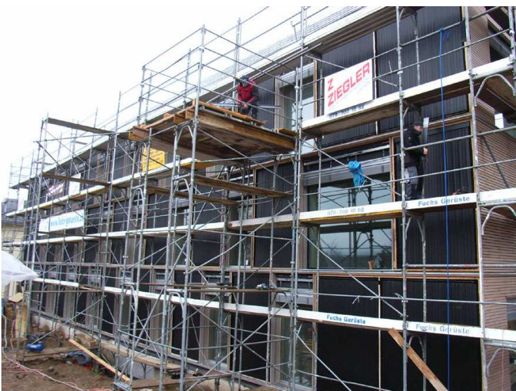
Abbildung 3-6: Montage der Kollektorverglasung
