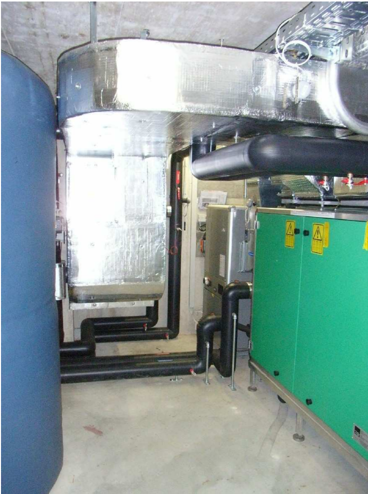
Abbildung 4-7: Nachisolation der Zu- und Abluftkanäle
