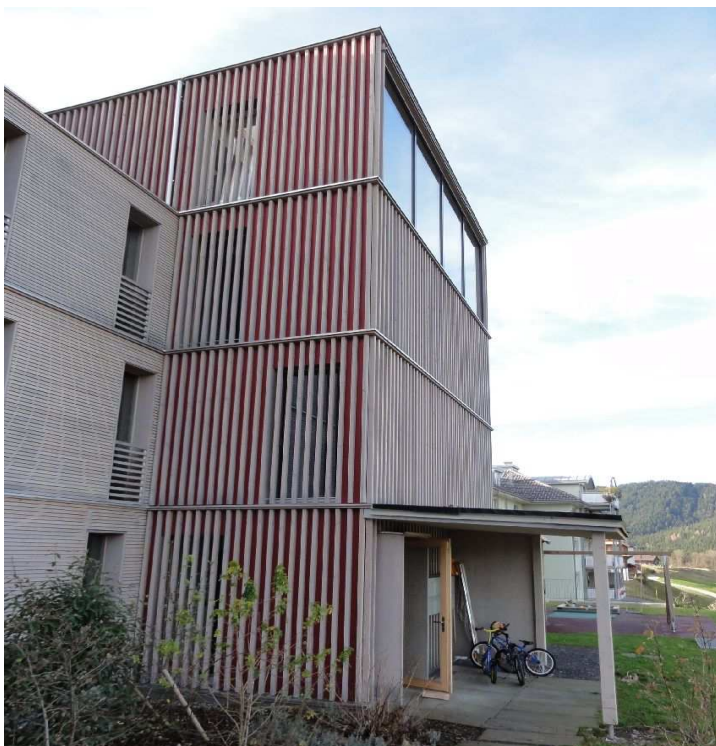
Abbildung 4-10: Das externe Treppenhaus.
