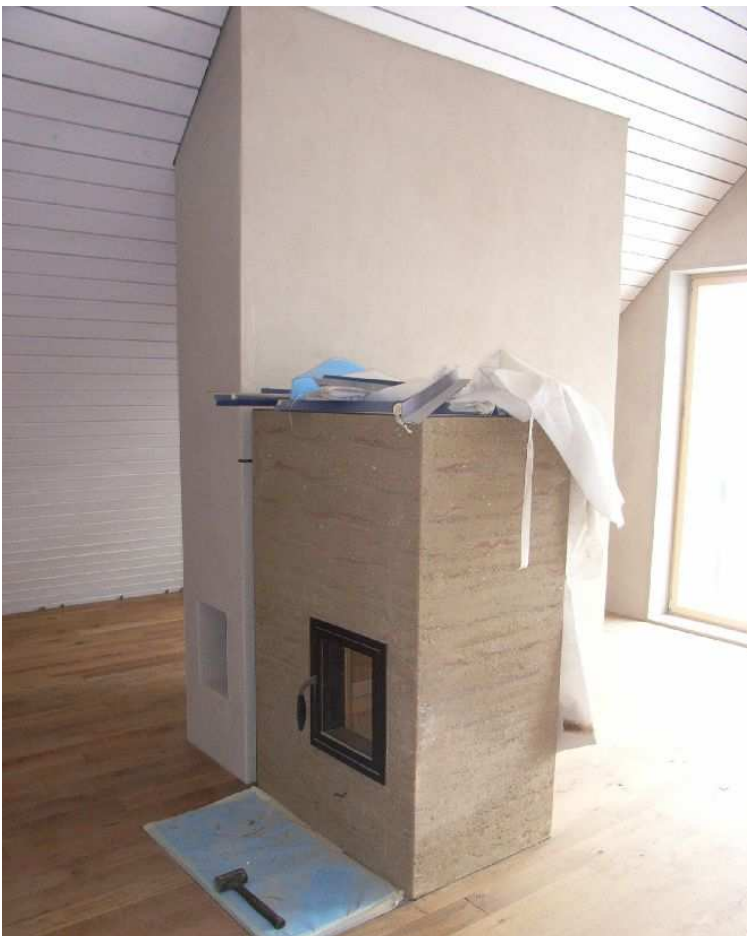
Abbildung 3-16: Speicherofen aus Lehmsteinen ("Lehmo") während der Montage.
