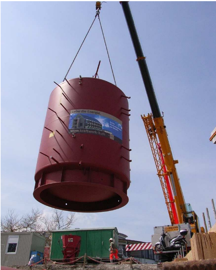
Abbildung 3-8: Einbringung des "grossen" Heizungswärmespeichers
