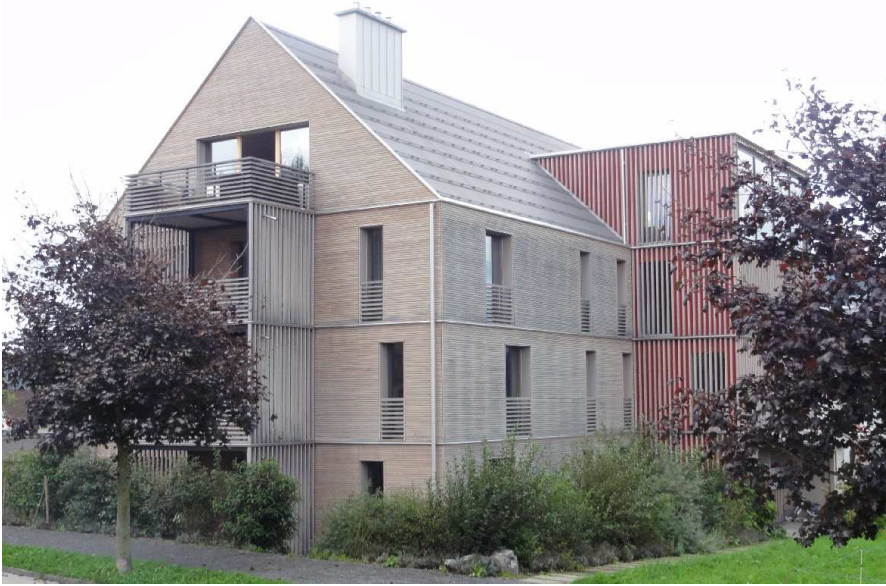
Abbildung 3-3: Ostansicht mit kleinen Fensteröffnungen gegen Norden und dem, ausserhalb der Wärmedämmebene gelegenen, unbeheizten Treppenhaus als Windfang und Pufferzone.
