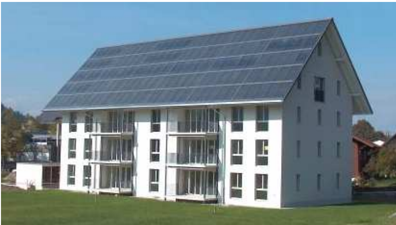
Abbildung 4-24: Plus-Heizenergie- MFH der Firma Jenni in Oberburg bei Burgdorf
