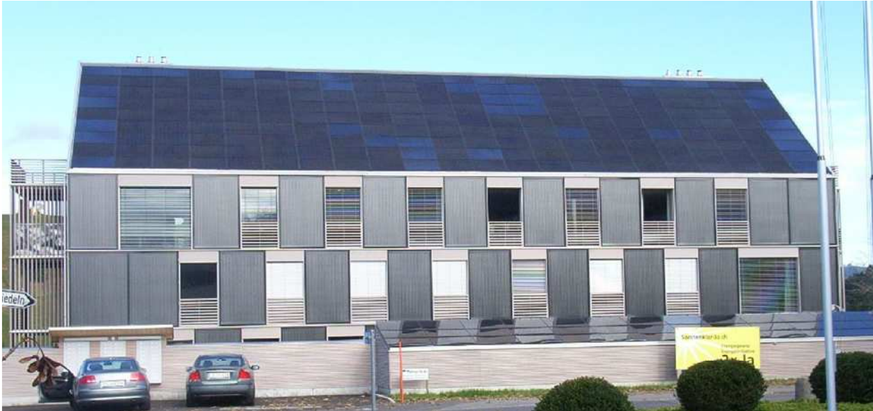
Abbildung 4-11 Südwestansicht des "Normalfalles" bezüglich Storenstellung:
