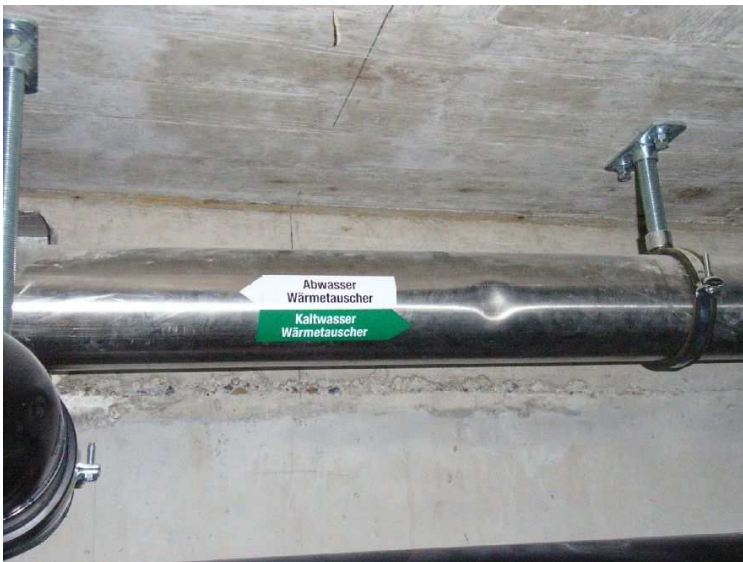
Abbildung 3-10: Doppelrohr-Abwasser-Wärmetauscher.
