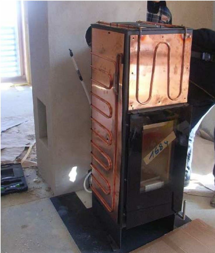
Abbildung 3-13: Der Kern des Absorber-Speicherofens beim Platzieren und Anschliessen - Ansicht von vorne
