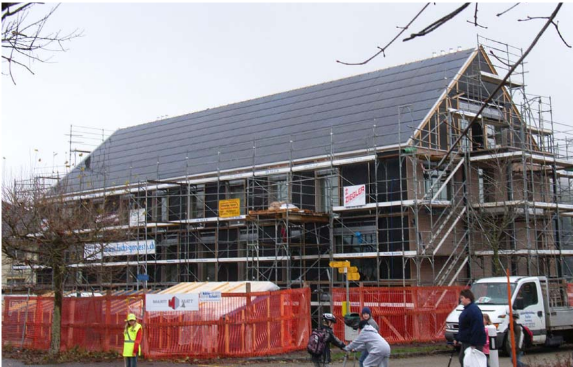
Baufortschritt aufgenommen am 13. November 2008. Photovoltaik (Dach) und die Absorber der Fasadensolarkollektoren sind montiert (das Verglasen letzterer steht kurz bevor).
