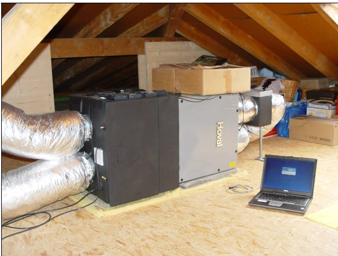
Figur 13: Wohnungslüftungsgerät im Dachgeschoss
