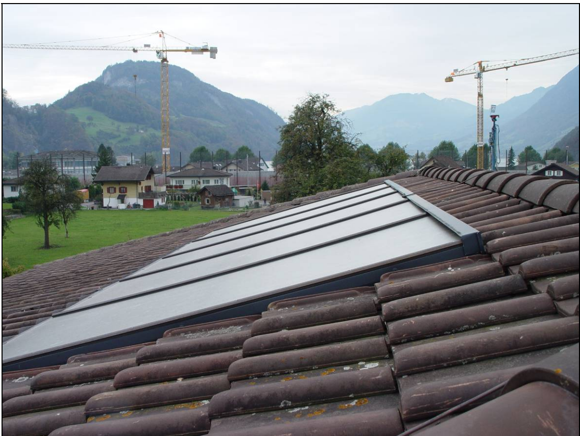
Figur 15: Sonnenkollektoren auf dem Dach
