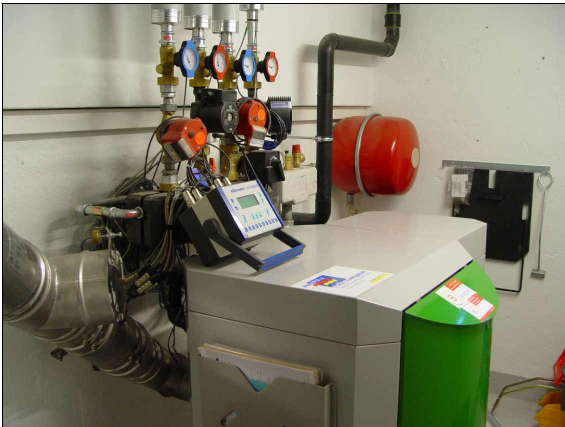
Figur 12: Pelletkessel im Technikraum
