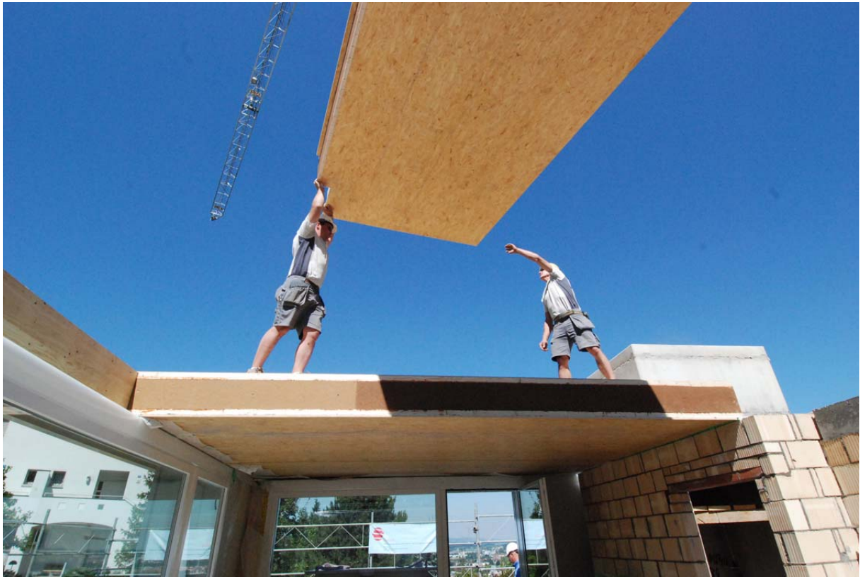
Abb. 1 Montage des vorfabrizierten Attikageschosses in hochisolierender Holzleichtbauweise
