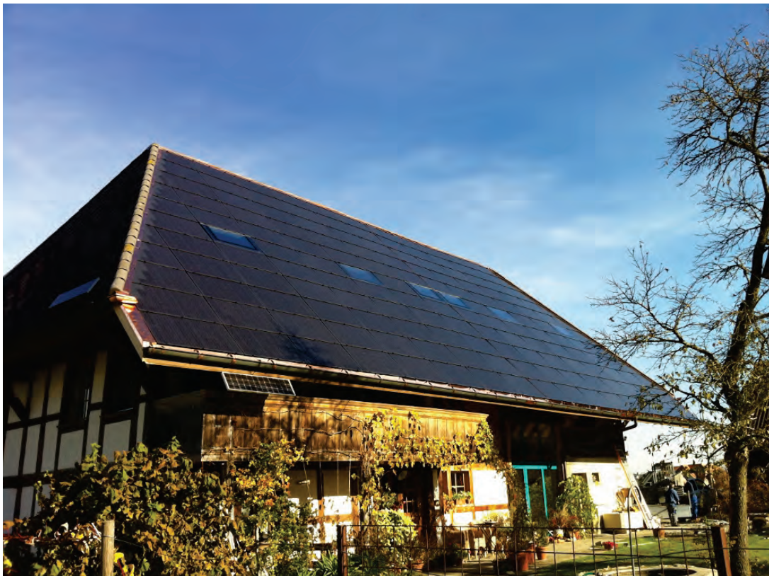
ABBILDUNG 9 ANLAGE MIT INTEGRIERTEN DACHFENSTERN
