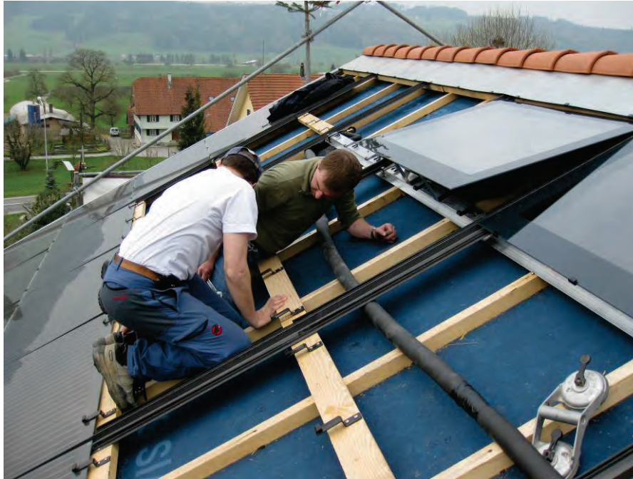
ABBILDUNG 8 MEGASLATE® II THERMIEPANELE WÄHREND DER MONTAGE
