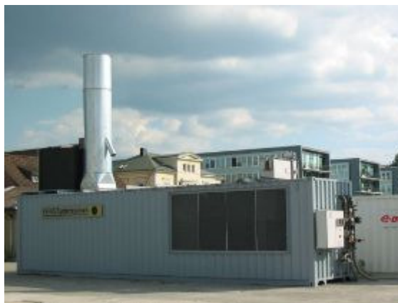
Figure 32: sécheur à bandes dans un conteneur de 12m [source : Ceres-sepatherm]
