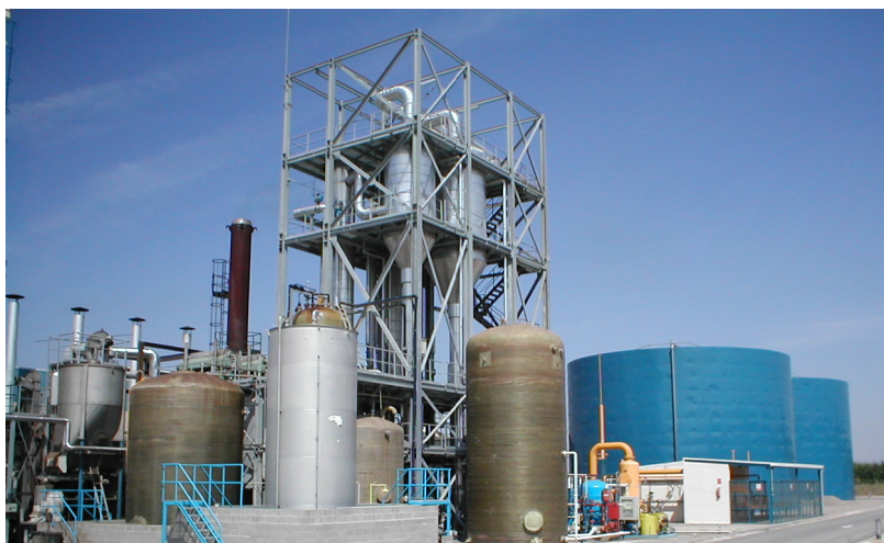
Figure 28: installation d'évaporation de 108'000 t/an pour le traitement du lisier porcin digéré [source : GEA Wiegand]
