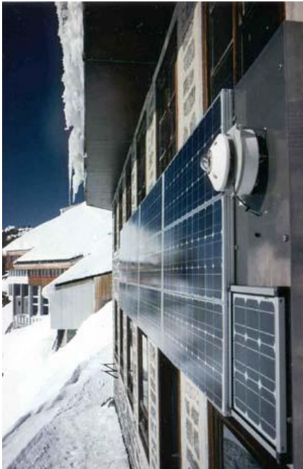
Abb. 15: Photovoltaikanlage Jungfrauoch
