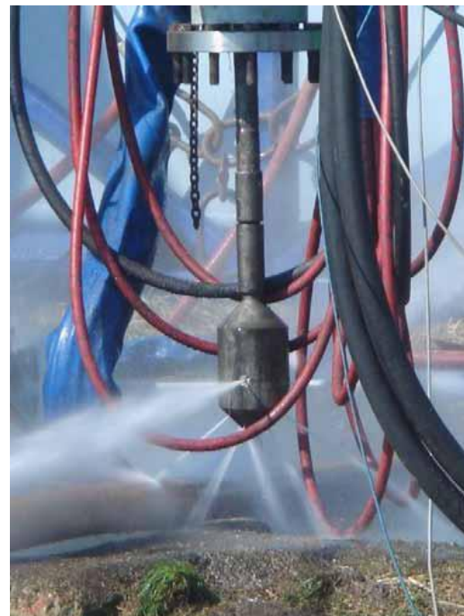
Fig. 5 et 6 Unité de Coiled tubing : injection d'eau sous pression dans un tube métallique
