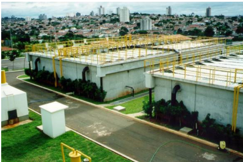
Abb. 37: A) UASB-Reaktoren zur anaeroben Behandlung industrieller Abwässer. Für die Reinigung kommunaler Abwässer könnten ebenfalls UASB Reaktoren zum Einsatz kommen, ohne die Grundfläche zu vergrößern. Bilder: A) Urs Baier, Fa. Frutarom Wädenswil. B) UASB Reaktoren in Brasilien, Firma AquaLim pia Consultores, Brasilien.
