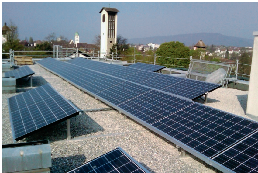
Abb. 5 Photovoltaik-Anlage des Alters- und Pflegeheim Rheinfelden, 31 kW pv , Inbetriebnahme Mai 2010.
