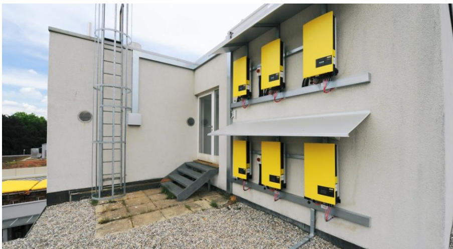
Abbildung 21: Wechselrichterplatzierung auf dem Dach des Alters- und Pflegeheims
