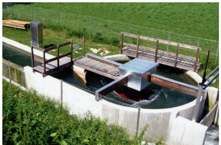
Abb. 8 Wasserwirbelkraftwerk in Obergrafendorf (A).
