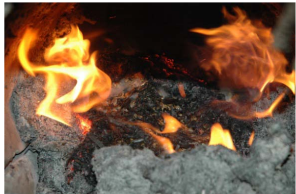
Abb. 5: Die Verbrennung war verbunden mit einer starken Verschlackung des Glutbetts (links). Rechts ist sichtbar, dass am Rande des Glutbetts die Luftzufuhr zu hoch (Flammen) und in der Mitte des Glutbetts keine Verbrennung erfolgte. Die Neueinstellung der Feuerung schaffte Abhilfe.
