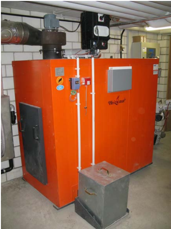
Abb. 3: Pilotfeuerung Heizomat RH-AK 35, die von der Firma Iseli, Wauwil installiert und von Christian Schenk, Weinfelden betrieben wird.
