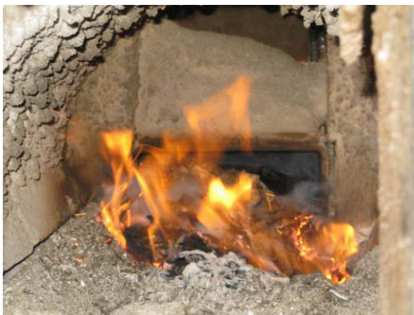
Abb. 4: Das Glutbett der Feuerung wird durch einen Kratzboden bewegt. Rechts ist der Kettenantrieb sowie eine Kratzbodenleiste (Pfeil) sichtbar.
