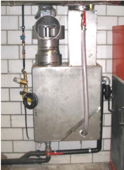
Abb. 12: Der Wäscher Racoonizer der Firma Enerclean besteht aus einem Wasserbecken (Bild links, unten) von welchem das Wasser über den Schlauch nach oben auf eine 4-stufige Treppe (Bild rechts) gepumpt wird.
