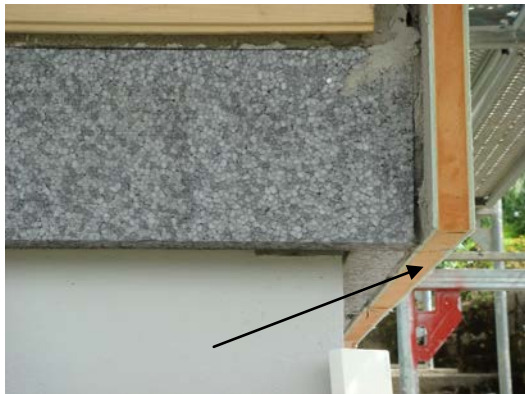
Figur 1: Mit dünnen Hartplatten geschütztes Vakuumisulationspaneel (VIP) für den Einsatz in Fassaden. Der seitliche Randschutz (rötlich) ist aus Phenolharzschaum (PF).
