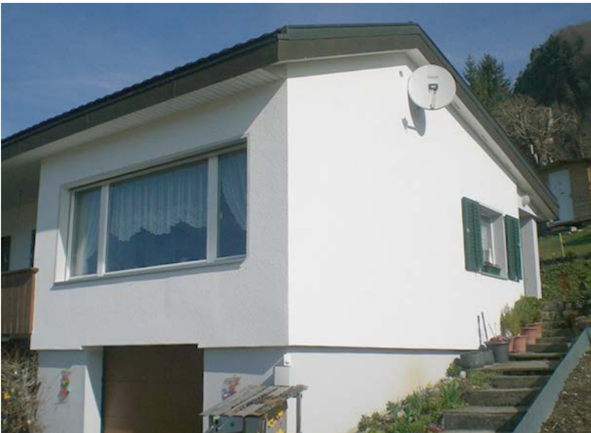
EFH Frei, Süd- und Ostfassade
