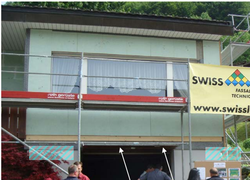
Figur 15: Südseite mit teilweise montierten Platten 28.5.2008. Nachträglich angebrachte unterste Reihe mit teils überdeckender Schraffur angedeutet. Weiter sind die Stösse der Hartplatte sichtbar, die das VIP schützen.
