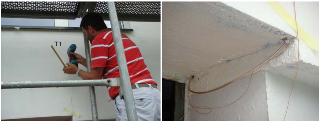
Figur 10: Montage der Sensoren an der Südfassade am 26.6.2008
