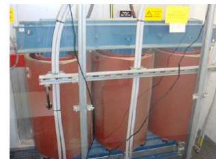
Abbildung 10: gemessener Trafo 6 kV / 0.69 kV (aus [2])
