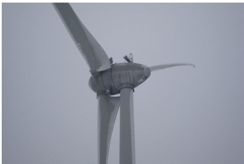
Abb. 28: WEA 1 mit abgeschalteter Blattheizung und vereisten Rotorblättern.
