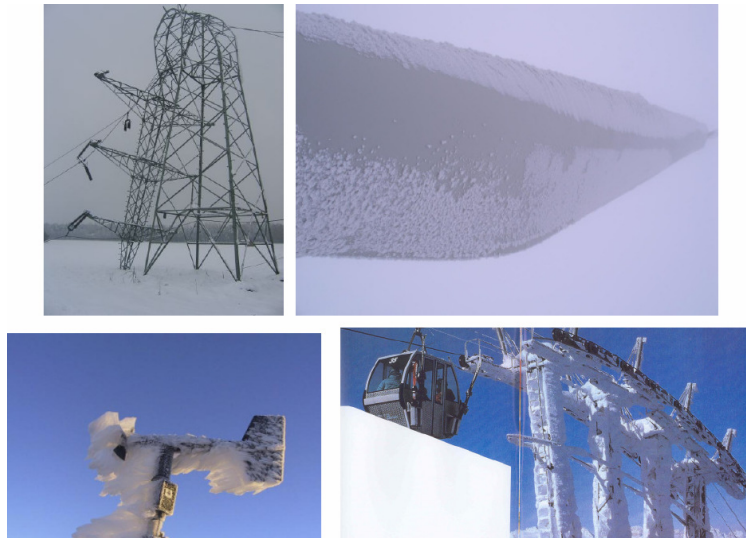
Abb. 2: Die Vereisung an Strukturen betrifft viele Bereiche. Oben links: Wegen Vereisung eingestürzter Mast einer Hochspannungsleitung. Oben rechts: Vereisung am Rotorblatt einer WKA. Unter links: Vereistes Propelleranemometer. Unter rechts: Vereisung am Mast einer Seilbahn.
