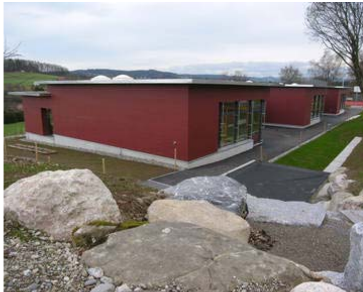
Abbildung 1: Aussenansicht Kindergarten Illnau-Effretikon
