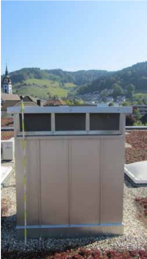
Figur 52: Aussenluft-Fassung mit den einzelnen Steigleitungen.
