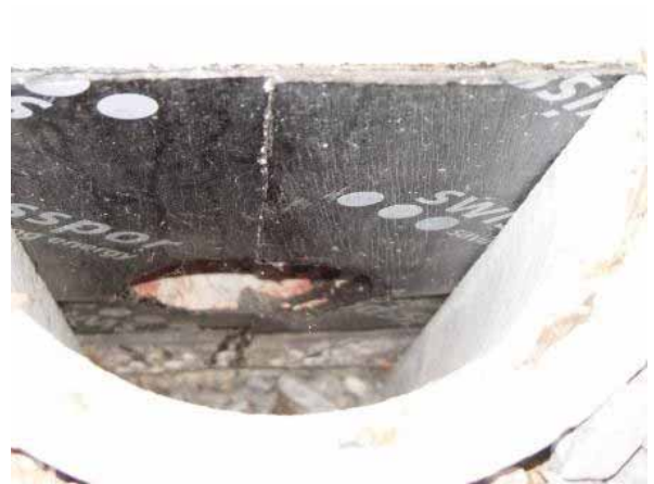
Figur 87: Fortluftöffnung ohne Gitterschutz.
