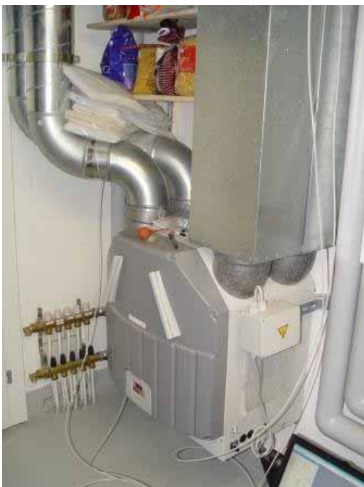
Figur 88: Lüftungsgerät im Hausanschlussraum.
