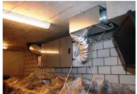
Figur 41: Lüftungsgerät.
