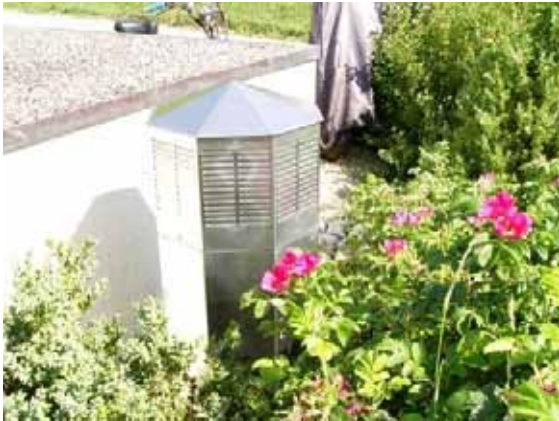
Figur 97: Aussenluftansaugung.
