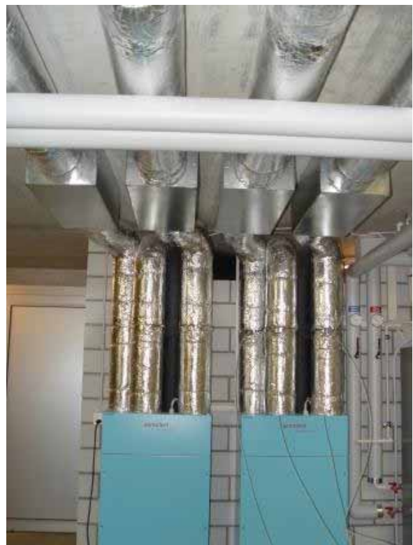
Figur 135: Lüftungsleitung mit Schalldämpfer.
