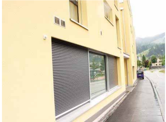
Figur 34: Strassenansicht mit Aussenluft- und Fortluft-Gitter.
