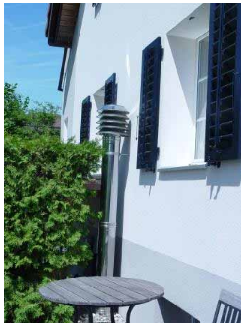
Figur 109: Aussenluftfassung.
