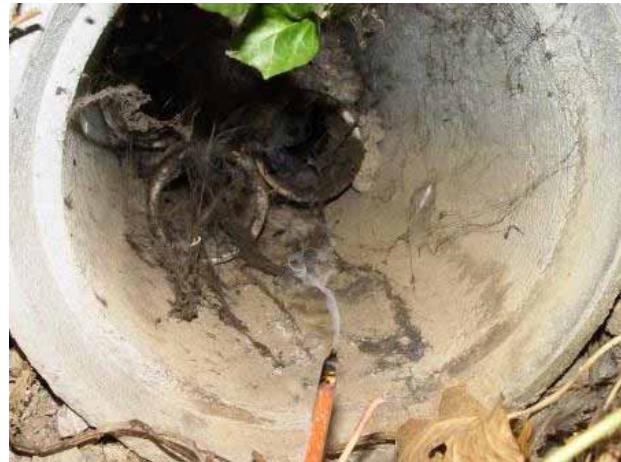
Figur 76: Erdregisterrohr bei der Aussenluftfassung.
