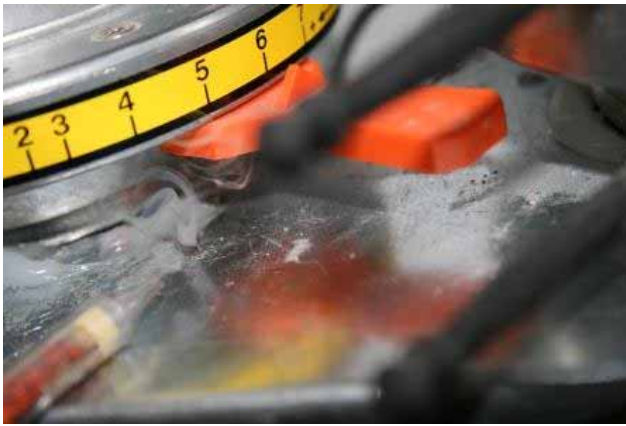
Figur 166: Leckage an den Verteileranschlüssen.
