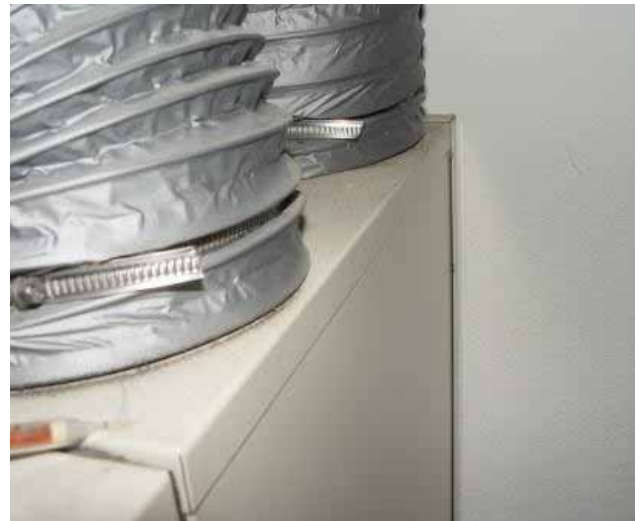
Figur 80: Undichtigkeiten an den Anschlüssen am Lüftungsgerät.
