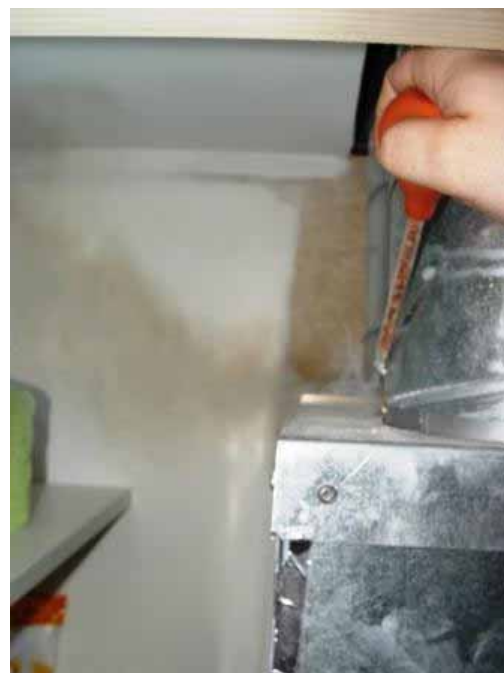
Figur 64: Undichtigkeit an ZUL-Anschluss.
