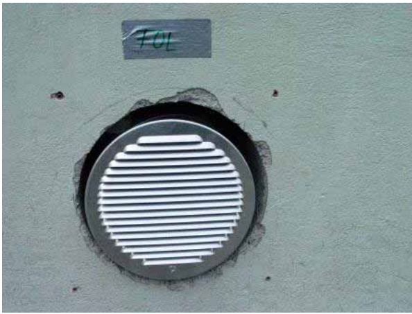
Figur 23: Fortluftgitter (zur Messung am Rand abgedichtet, im späteren Verlauf wird es noch eingeputzt).
