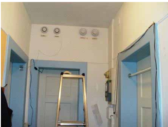
Figur 27: Fluransicht mit ZUL- und ABL-Öffnungen (vor Sanierung)
