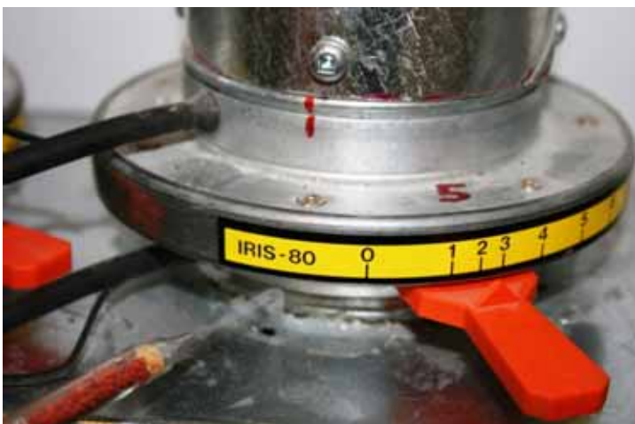
Figur 8: Einsatz eines Rauchröhrchens zur Leckageortung.
