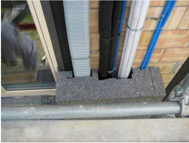
Figur 154: Leitungsführung in der Dämmschicht.
