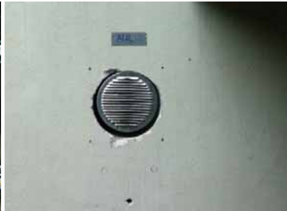
Figur 26: Aussenluftgitter (gleiche Bedingung wie FOL).
