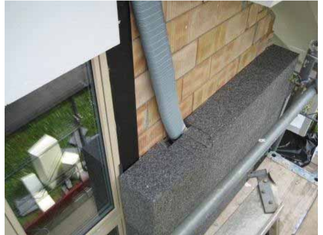
Figur 155: Lüftungsleitung an der Aussenwand in der Dämmung.
