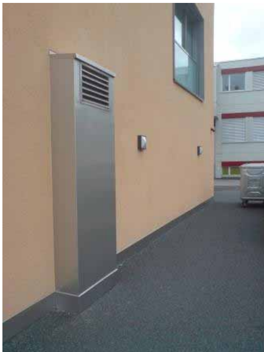
Figur 175: Aussenluftfassung Höhe ca. 2.2m
