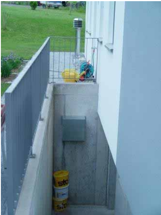
Figur 145: Kellereingang mit Fortluft-Box.
