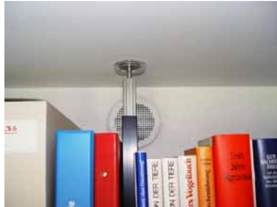
Figur 98: ZUL-Gitter im Büroraum.
