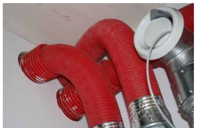
Figur 165: Anschlüsse vom Verteiler in das Netz.
