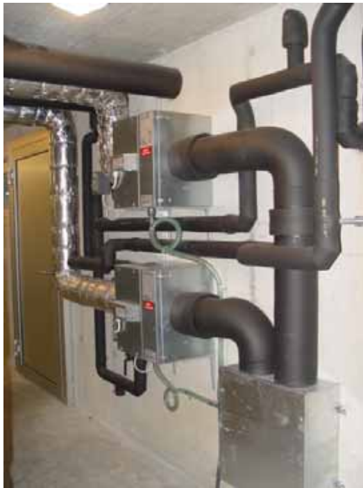
Figur 136: Aussenluft-Ansaugung mit Vorerhitzer.
