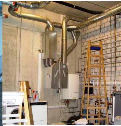
Figur 121: Lüftungsgerät im Hauswirtschaftsraum.
