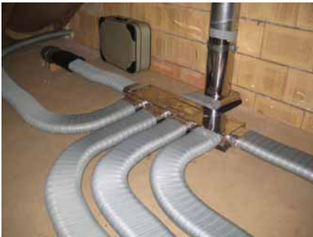
Figur 156: Verteiler im Dachboden.
