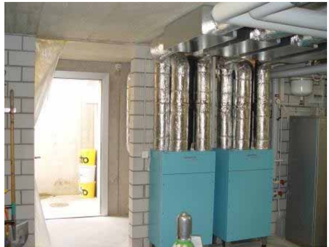
Figur 137: Aufstellort mit Kellertür und Fortluft-Kasten (oben rechts in der Zarge).
