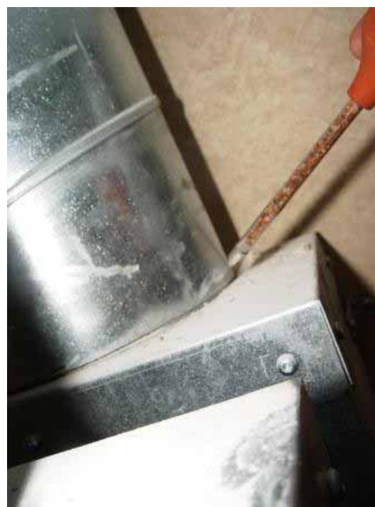
Figur 66: Undichtigkeit an ABL-Anschluss.
