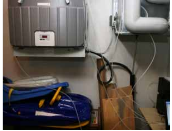
Figur 14: Lüftungsgerät mit Kondensatablauf nachher.
