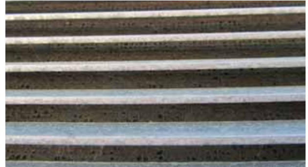
Figur 53: Stark verschmutztes Gitter der Aussenluft-Fassung.
