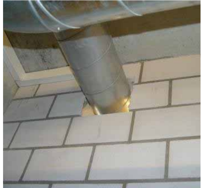
Figur 125: Trennwand zwischen Aufstellraum und Aussenluftansaugung.
