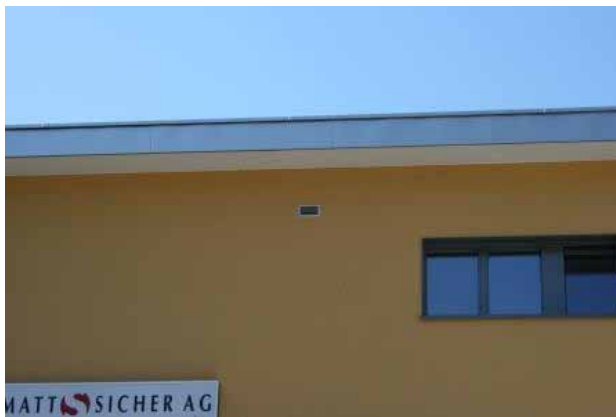
Figur 160: Aussenluft-Ansaugung
