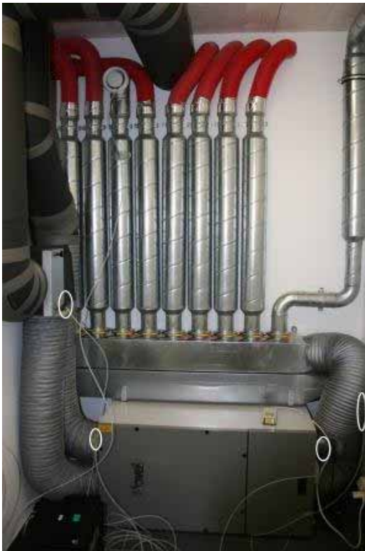
Figur 168: Messpunkte für Konzentration und Druck.
