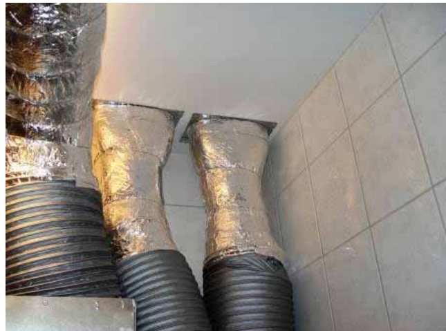
Figur 36: Anschlüsse vom Gerät an die Verteilung.
