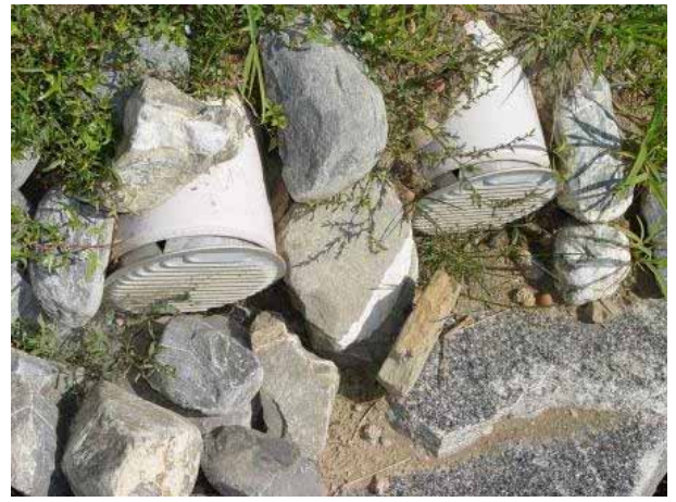
Figur 85: Aussenluftansaugung über Erdregister.
