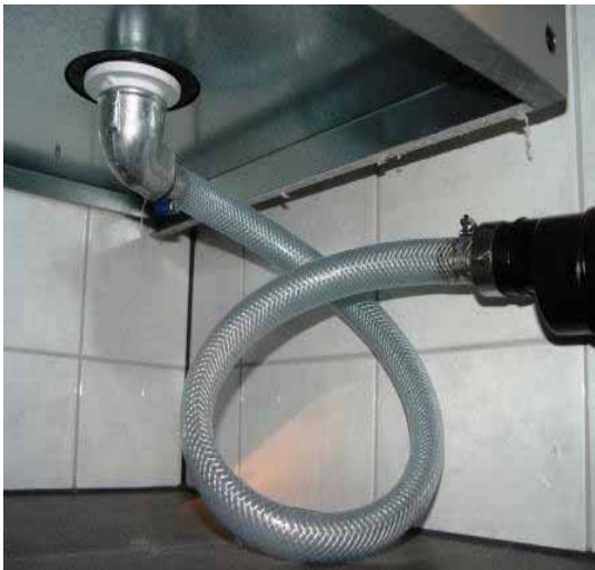
Figur 35: Kondensatleitung vom Lüftungs- gerät.
