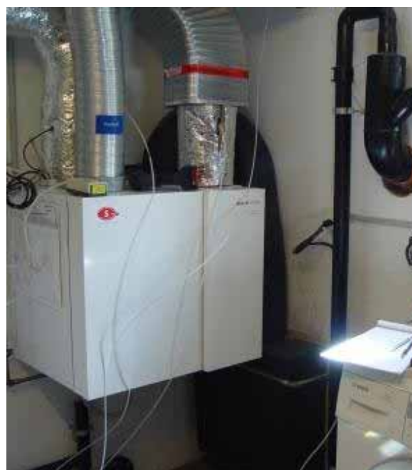
Figur 111: Lüftungsgerät mit Tracergas- Mehrpunktsampling.
