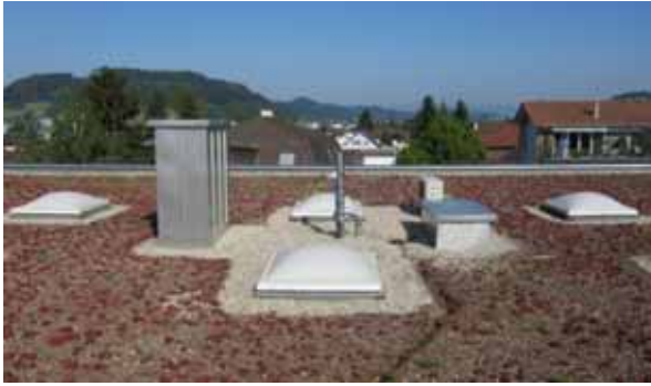
Figur 50: Dachansicht mit Aussenluft- und Fortluft-Fassungen.
