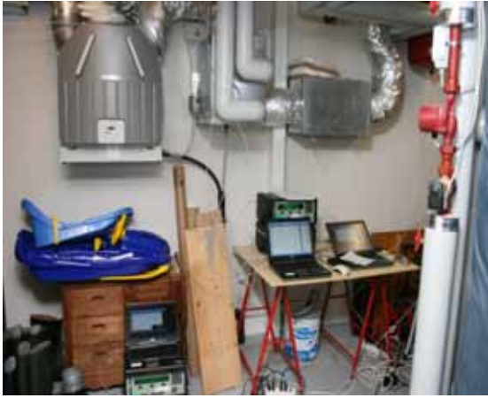
Figur 13: Lüftungsgerät mit Filter (rechts) und Kondensatablauf vorher.
