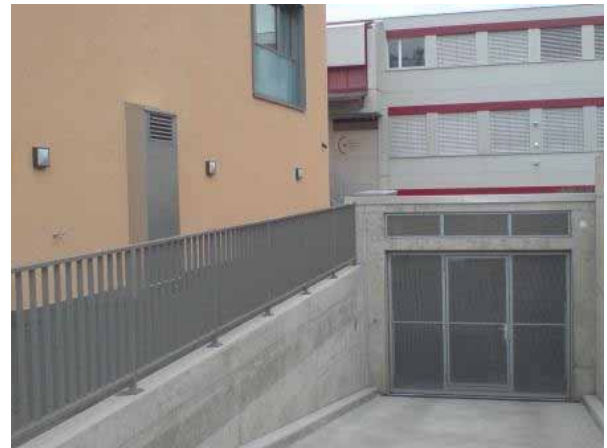
Figur 174: Aussenluftfassung und Einfahrt zur Tiefgarage.
