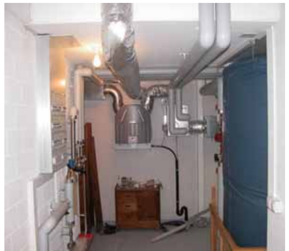
Figur 16: Lüftungsgerät im Keller.
