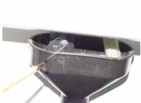
Figur 78: Ansaugung über Siphon am Lüftungsgerät.
