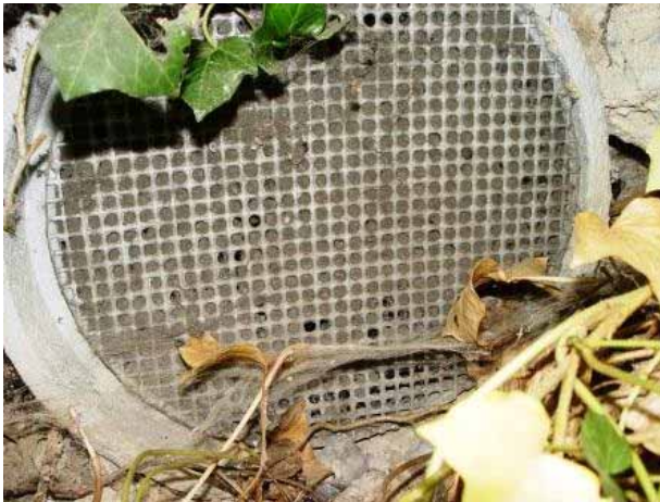
Figur 75: Gitter von der Aussenluftfassung.
