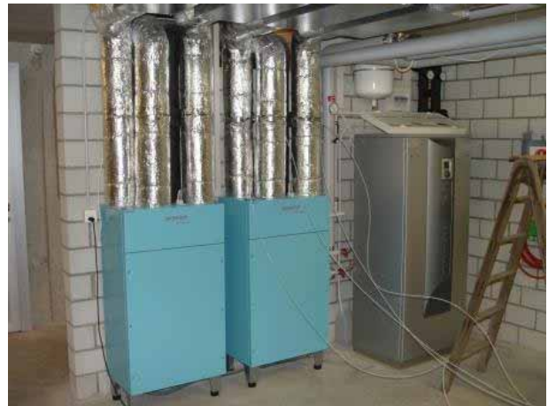
Figur 133: Lüftungsgeräte im Keller.
