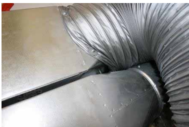
Figur 164: Hauptanschluss an den Verteiler.
