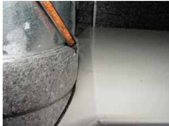
Figur 102: Undichtigkeit an den Anschlüssen.
