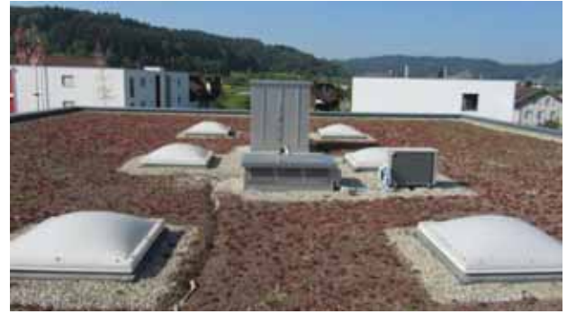
Figur 51: Vorne Fortluft- und hinten Aussenluft-Fassung.
