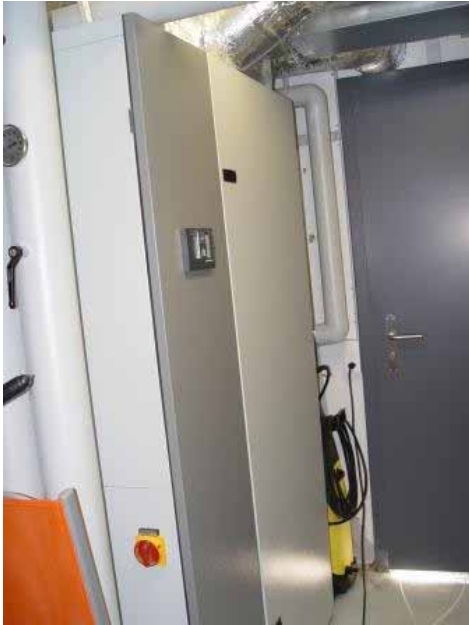
Figur 99: Kombigerät mit Wärmepumpe.
