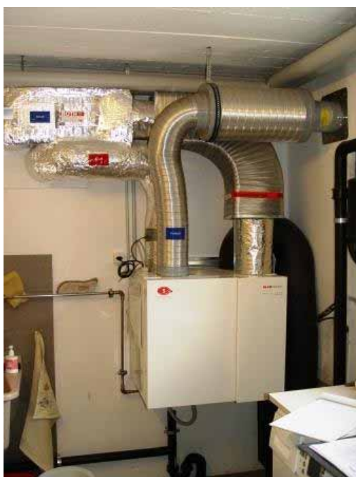
Figur 110: Lüftungsgerät mit Anschlüssen.
