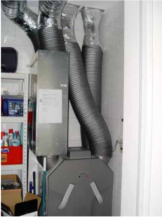
Figur 33: Lüftungsgerät im Vorratsraum.
