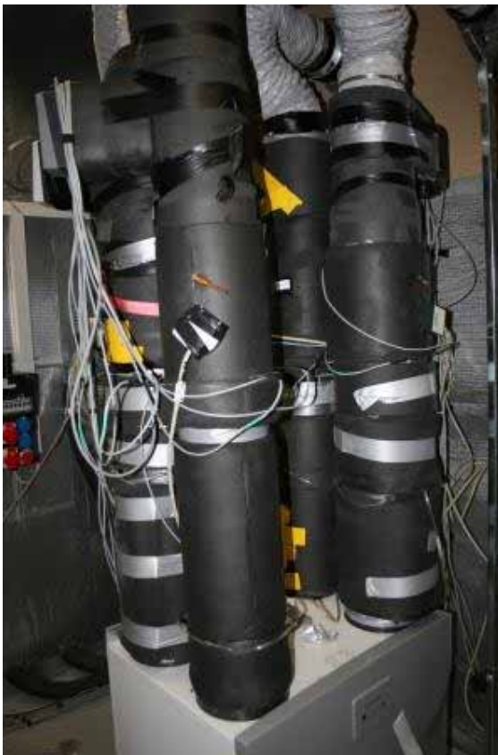
Figur 188: Feuchte- Temperaturfühler in den Anschlussleitungen.
