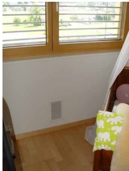
Figur 89: Zuluftgitter in Bodennähe.
