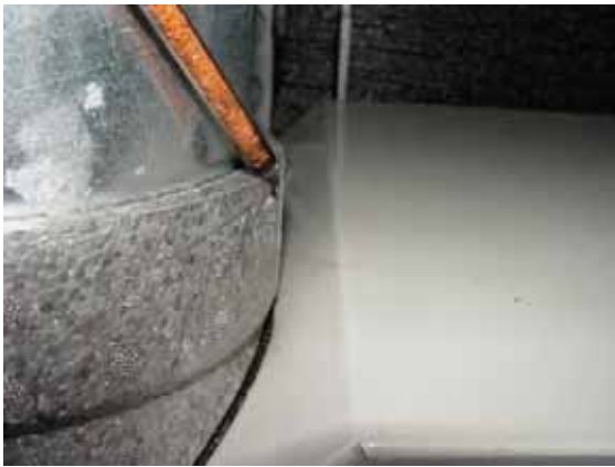
Figur 102: Undichtigkeiten der Anschlüsse am Lüftungsgerät
