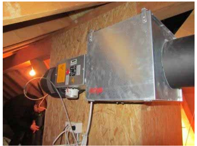
Figur 157: Vorerhitzer für Aussenluft im Estrich.
