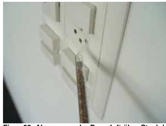
Figur 68: Absaugung der Raumluft über Steckdose.
