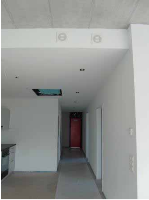
Figur 181: Küchenansicht mit Zuluftauslässen und Aerosilent-Gerät.
