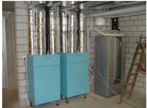
Figur 144: Lüftungsgeräte im Keller
