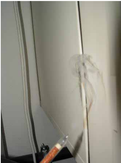
Figur 79: Undichtigkeit am Gehäuse der Lüftung.
