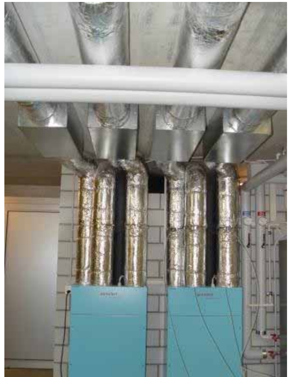
Figur 146: Lüftungsgeräte mit separaten Schalldämpfern.
