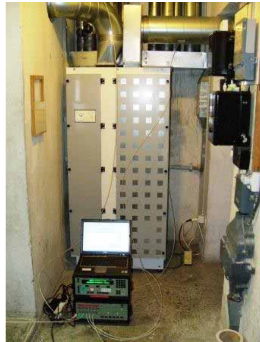
Figur 24: Lüftungsgerät mit Tracergas-Equipment.
