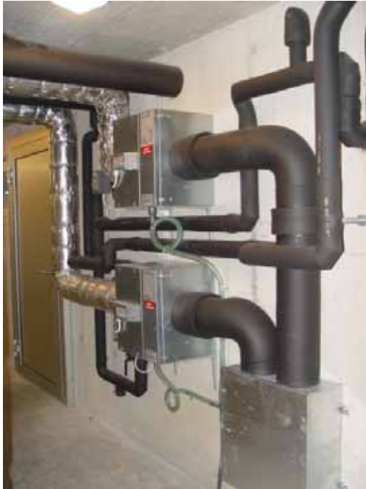
Figur 147: Aussenluftansaugung mit Vorerhitzern.
