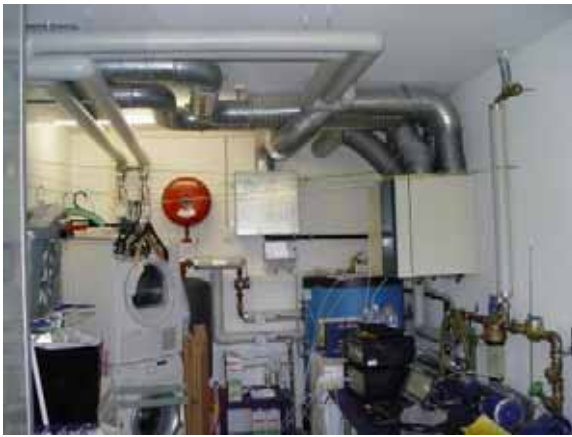
Figur 77: Lüftungsgerät im Hauswirtschaftsraum.
