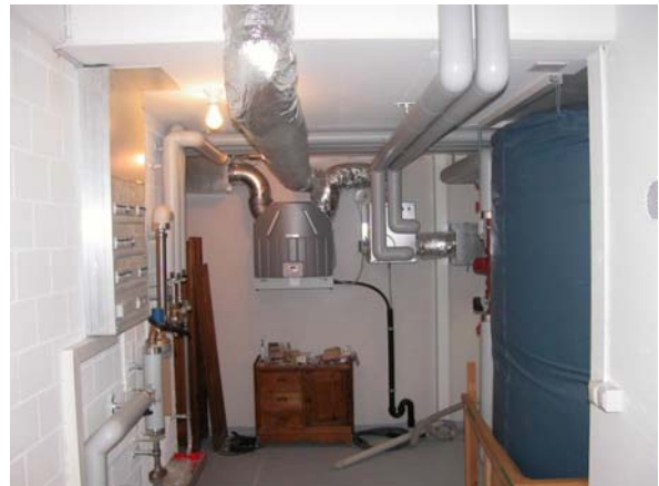
Fig. 4: Die Pilotanlage im Knonauer Amt mit einem spezifischen elektrischen Leistungsbedarf p_{SFP} von 0.31 \text{ W}/(\text{m}^3/\text{h}) .
