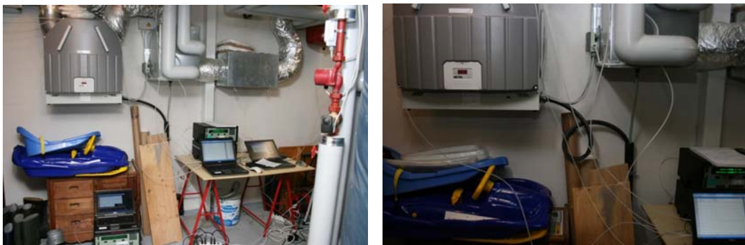
Fig. 6: Durch die korrekte Syphonierung (rechts) wird keine Umgebungsluft mehr über den Kondensatablauf in das Kompaktlüftungsgerät eingesogen.
