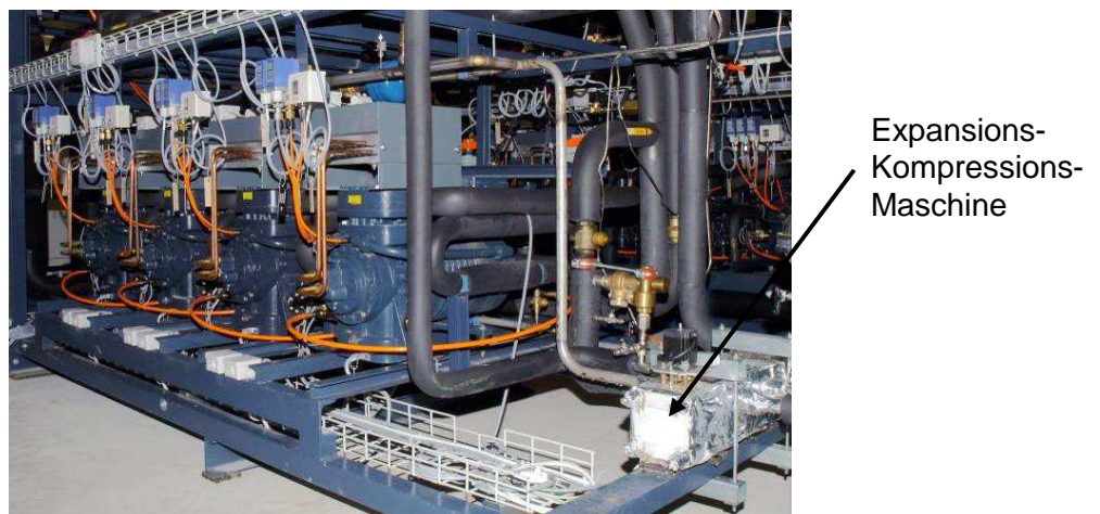
Figur 4: Verbundanlage zur Pluskühlung mit integrierter Expansions-Kompressions-Maschine im Feld
