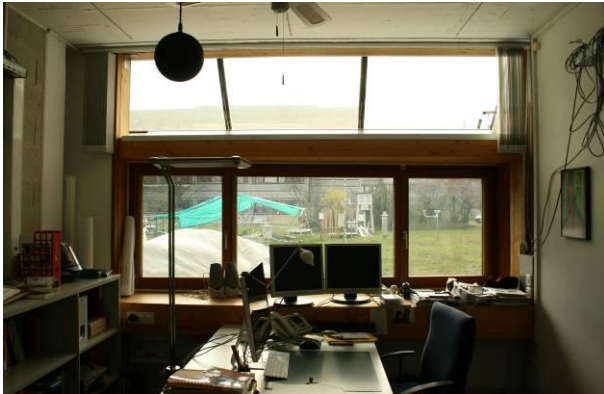
Vitrages EC dans l'état de transmission maximale (transmission énergétique 45 %)
