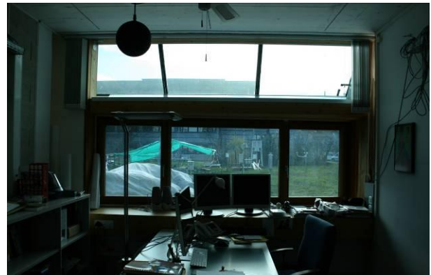
Vitrages EC dans l'état de transmission minimale (transmission énergétique 15 %)
